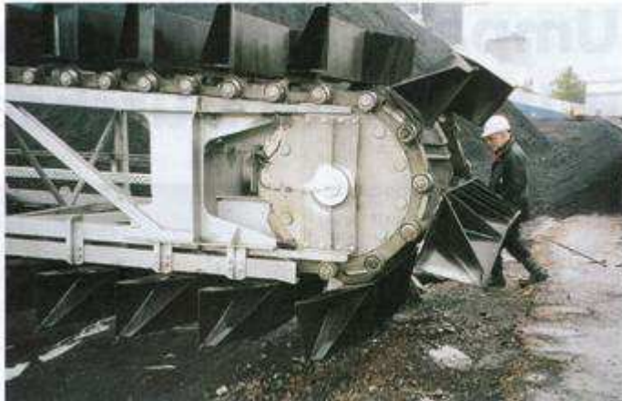
Die Geräuschbelastung der Anlage liegt dank der selbsteinstellenden Kettenräder deutlich unter den Vorgabewerten.
