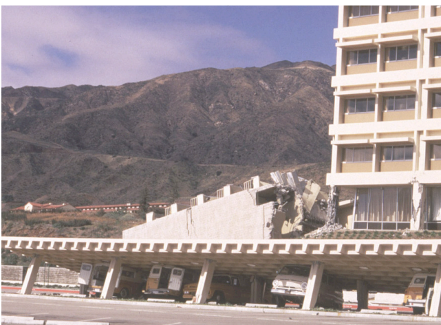
Abb. 1: Ambulanzfahrzeuge unter eingestürztem Vordach begraben nach dem San Fernando Erdbeben in Kalifornien 1971 (Foto: EERI)
