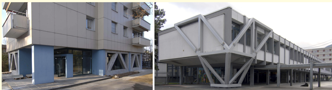
Bild 5. Erdbebenertüchtigung eines Wohngebäudes in Birsfelden bei Basel durch Stahlbetonfachwerke im Erdgeschoss (links) und eines Schulgebäudes in Monthey im Wallis durch räumliche Stahlfachwerke (rechts).
