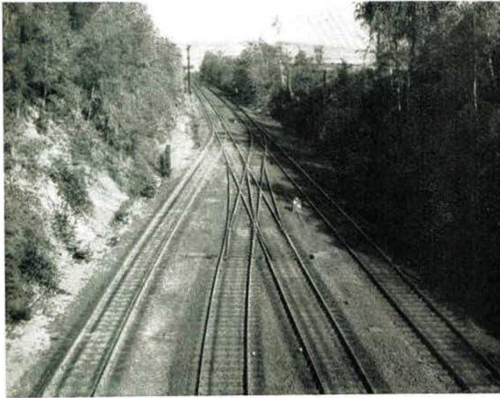
Bild 3 Einfahrt in den Bahnhof Klingenberg-Colmnitz aus Richtung Tharandt
