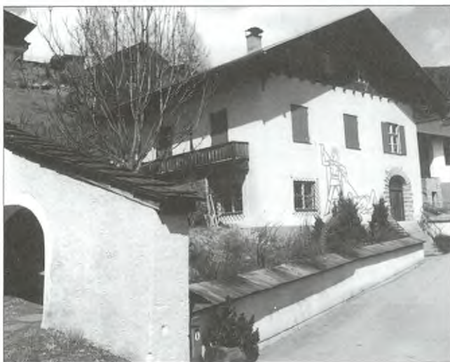
Der Pfarrsaal, wie er seit 35 Jahren das Dorfbild prägte, wird zu einem Kulturheim ausgebaut.
