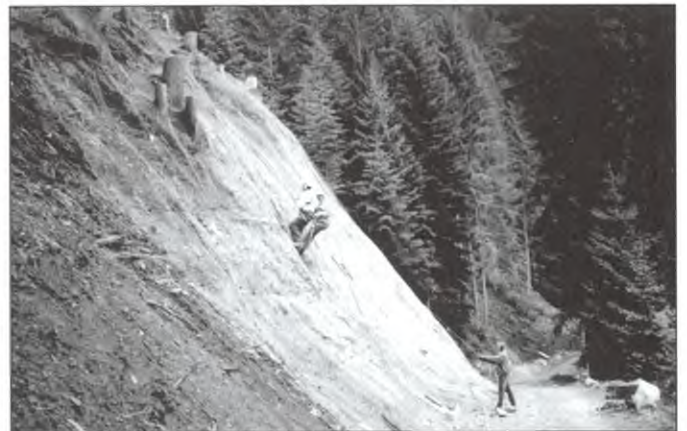
Böschungsbefestigung mit Drahtnetzen (vor der Begrünung) Libisell-Herol 19.05.99 Foto: W. Annewandter
