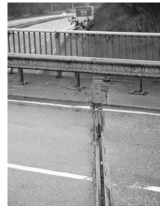
Verschiedene Maßnahmen zum Ausgleich der Längenausdehnung an Brücken, Fotos: PL/Ronny Schwarz
