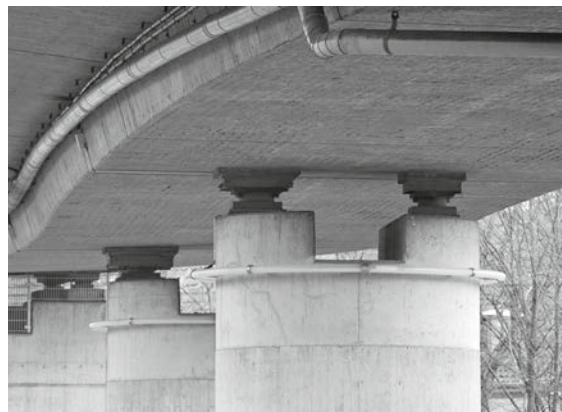
Verschiedene Maßnahmen zum Ausgleich der Längenausdehnung an Brücken, Fotos: PL/Ronny Schwarz
