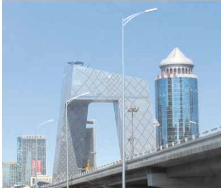
Peking baut: auf Vogelneest folgt Hosenträger. FOTOS: FELIX KELLER
