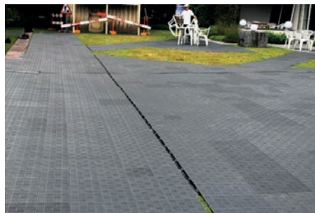
Bild 4: Richtig! Dehnungsfuge gleicht Wärmeausdehnung aus
