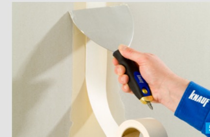
Einlegen des Fugendeckstreifens
