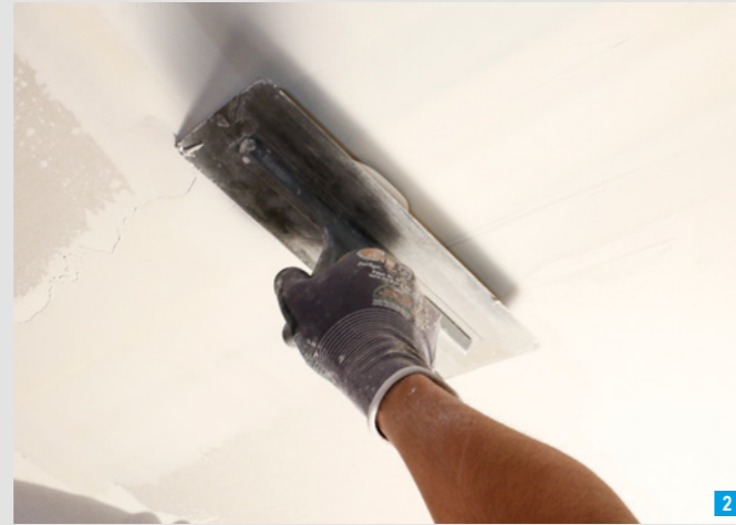
Mit Knauf Fill & Finish können sowohl AK-Fugen gespachtelt werden als auch Flächen in den Qualitäten Q3 und Q4.
