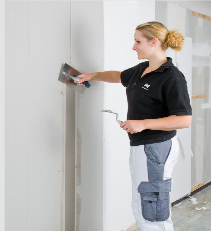
Risse sicher spachteln mit Knauf Spachtelmasse
