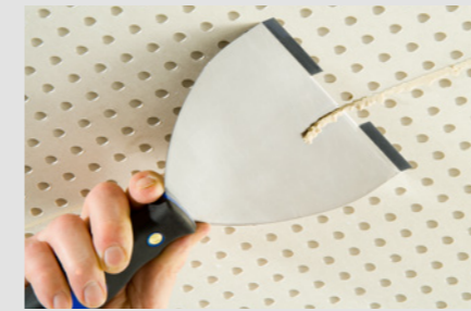
Abstoßen von überstehendem Knauf Uniflott nach dem Aussteifen mit der Cleaneo-Spachtel
