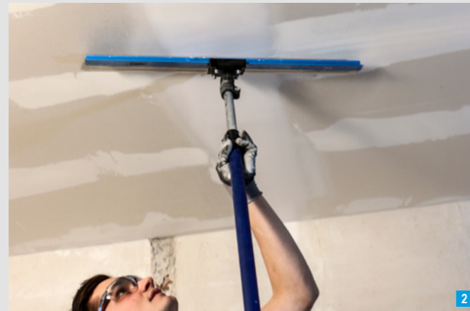
Durch die maschinelle Verarbeitung erreicht man eine um bis zu 5 x höhere Flächenleistung.
