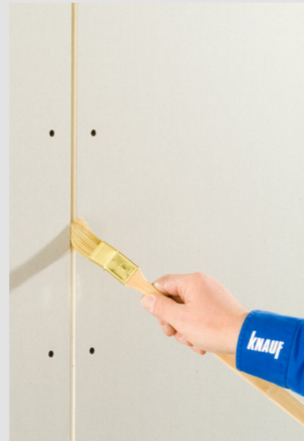
Aufbringen von Knauf Tiefengrund
