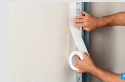
2 Trenn-Fix neben Profil kleben
