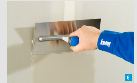
Überspachteln des Fugendeckstreifens
