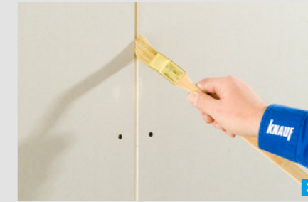
Fuge staubfrei machen
