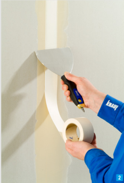
Einlegen des Fugendeckstreifens
