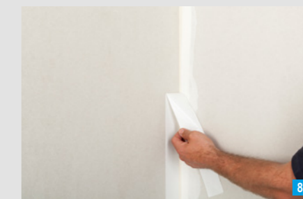
8 Überstehenden Streifen abziehen
