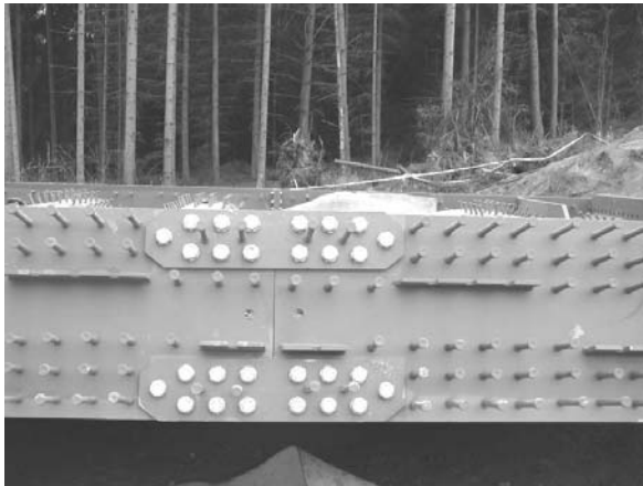
Bild 3.13: Obergurt mit Laschenstoß und Anschlussblechen für Schlaufenverbindung
