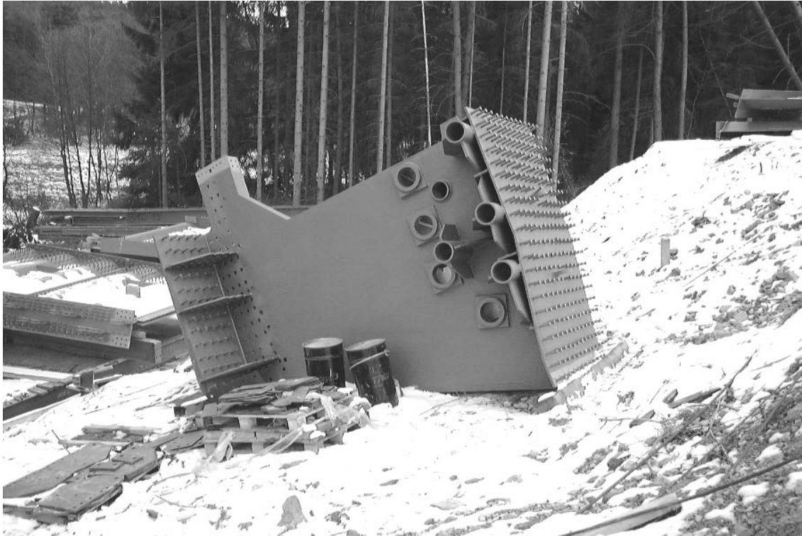
Bild 3.19: Antransport der Umlenkelemente
