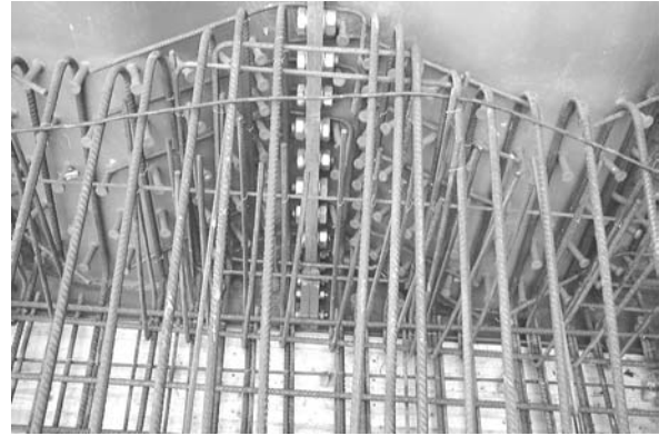
Bild 3.18: Bewehrung der Bodenplatte im Bereich der Sicken
