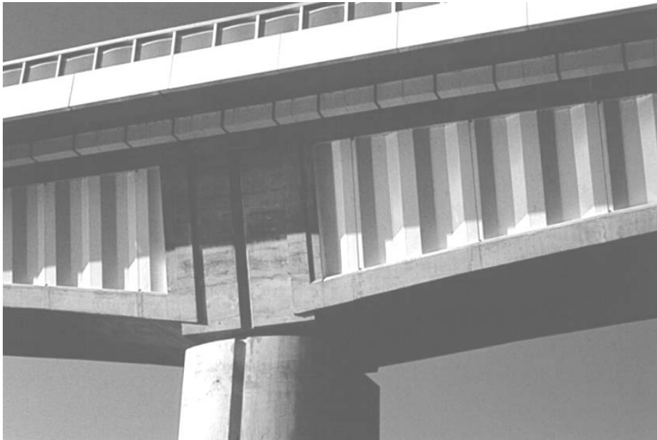
Bild 3.2: Voutenträger mit Trapezstegen in Frankreich
