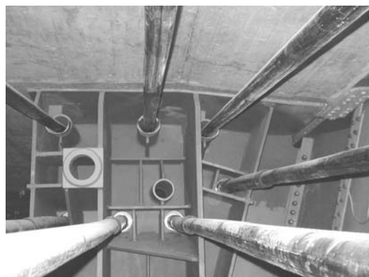
Bild 3.21: Ankerstelle der externen Vorspannung
