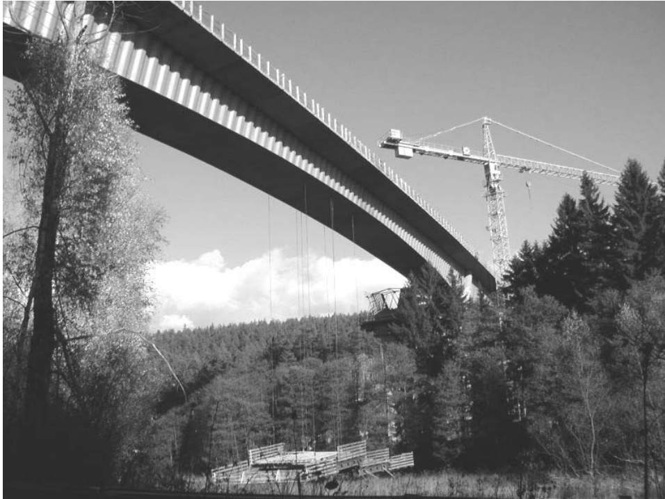
Bild 3.24: Fertiggestellter Überbau Süd
