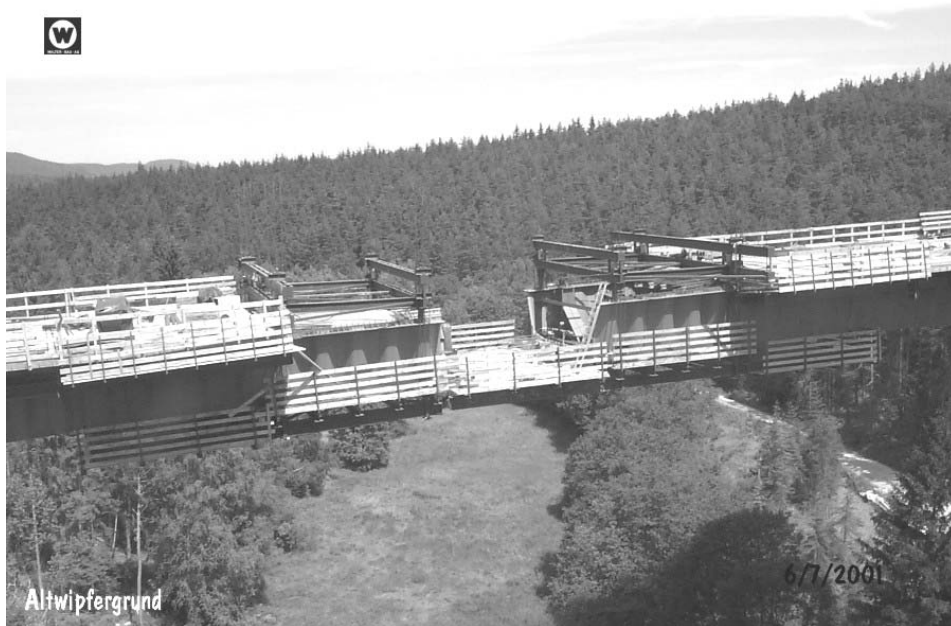
Bild 3.26: Herstellen des Schlusstückes
