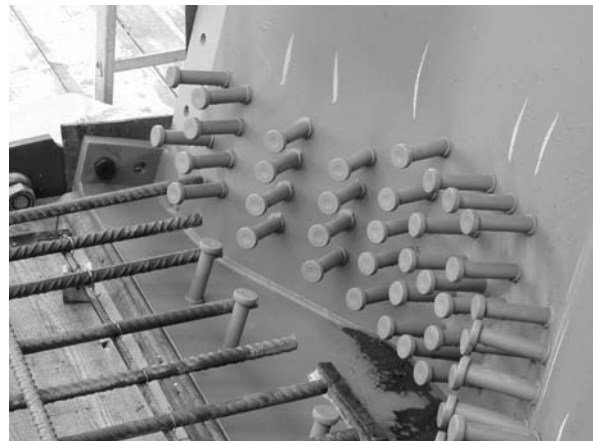
Bild 3.8: Detailansicht Untergurtanschluss an Kastenboden
