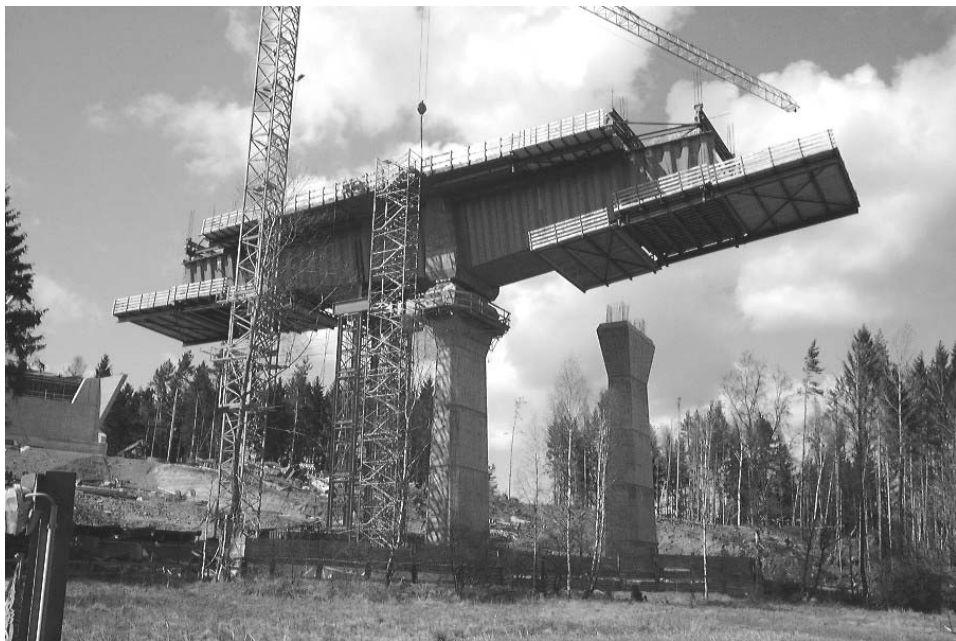
Bild 3.25: Beidseitiges Vorbauen von den Stützen aus
