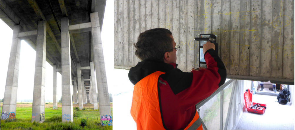
Bild 6: Untersichten der untersuchten Spannbetonbrücke und Messung an einem der Plattenbalken
