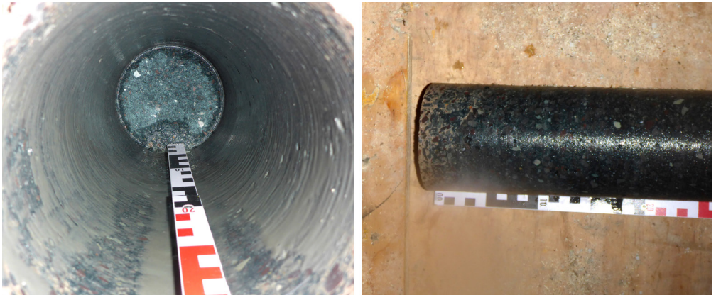
Bild 5: Kernbohrung durch Wandquerschnitt (im hellblauen Bereich in Bild 4); die angeschnittenen Stahlfasern im Bohrloch nahe der Wandoberfläche sind gut erkennbar
