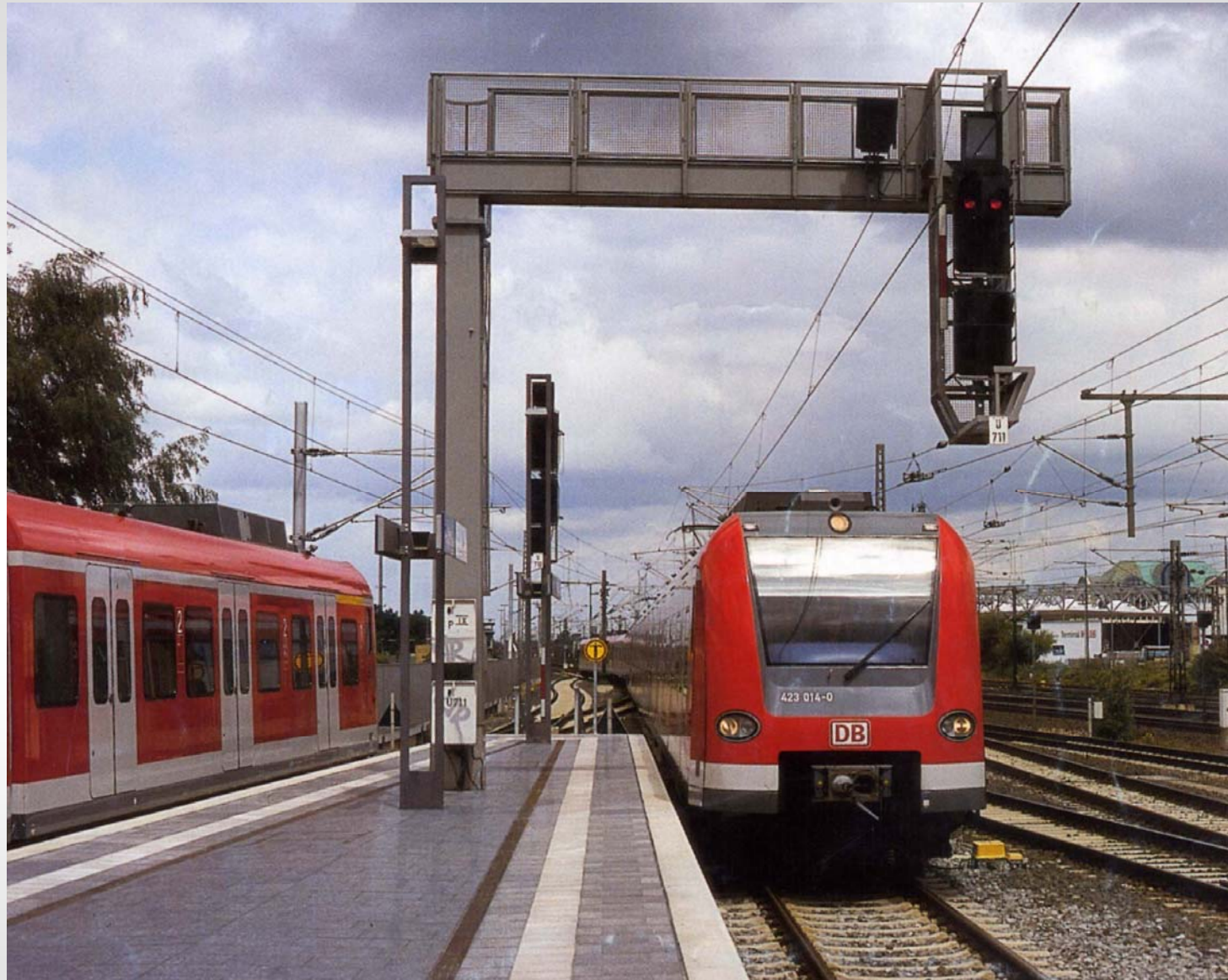
Signalbrücke bei zu geringem Gleisabstand
