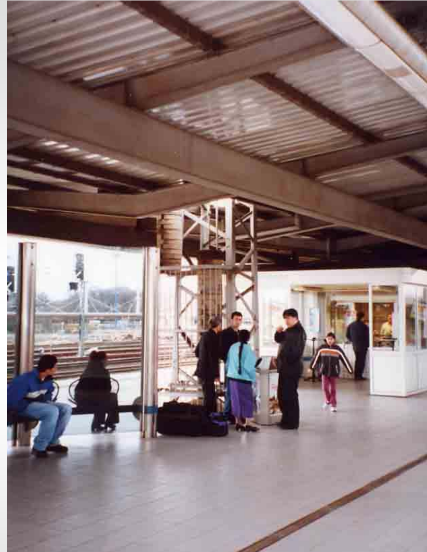
Anordnung von Oberleitungsmasten im Bereich von Bahnsteigdächern
