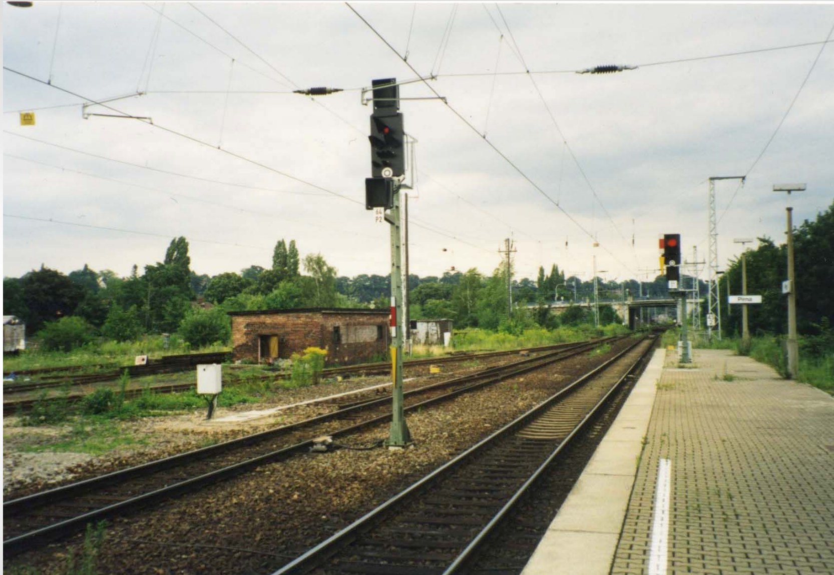
Signal mit Schalmast bei 4,50 m Gleisabstand
