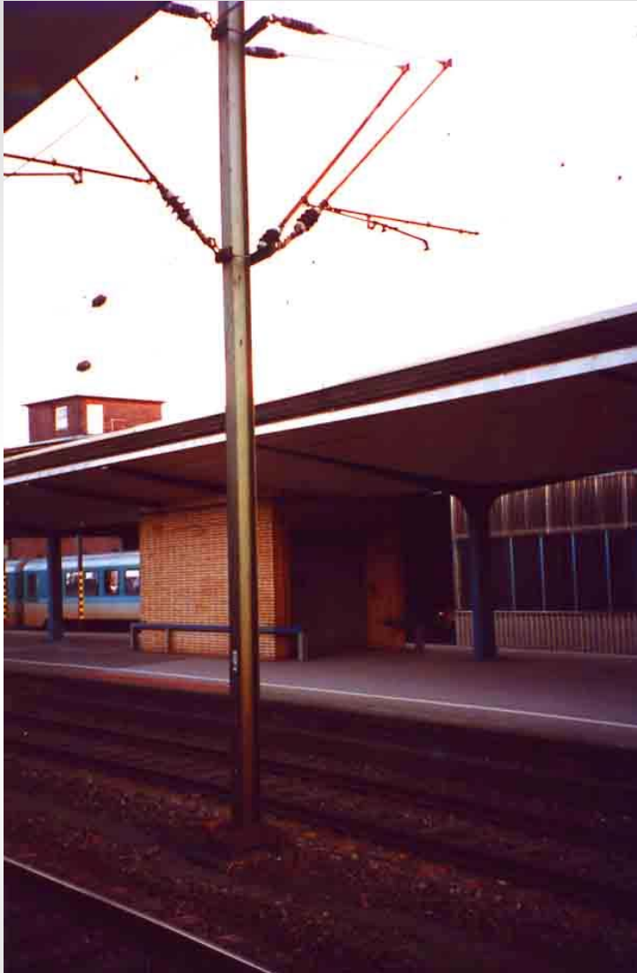
Anordnung von Oberleitungsmasten im Bereich von Bahnsteigdächern
