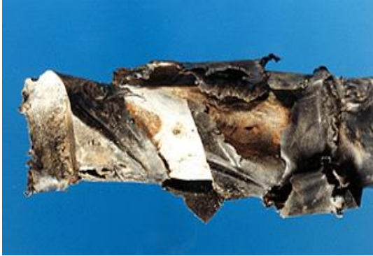
Trinkwasserrohr aus verzinktem Stahl http://www.korrosion-online.de
