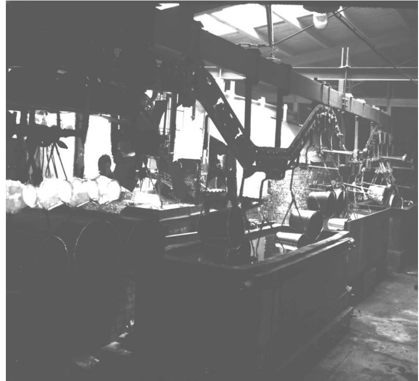
Kontinuierliche feuZn-Anlage für Stückgut 1951
