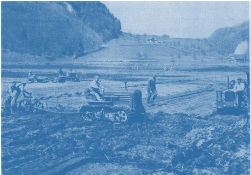
Für die Meliorierung des zähen Riedbodens im «Drachenried» müssen leistungsfähige, geländegängige Raupentraktoren eingesetzt werden
