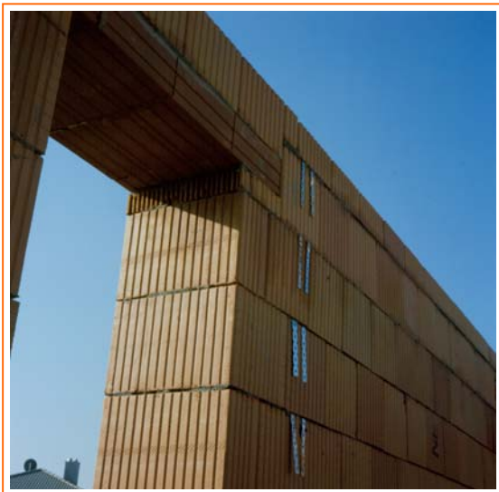
Bild 3: Fensterleibung mit Anfangsziegeln bieten einen ebenen, sauberen Untergrund.
