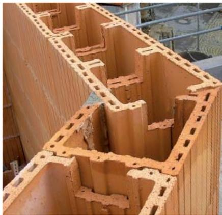
Selbst stumpfe Mauerecken mit hier 135° lassen sich mit Schalungsziegel elegant setzen
