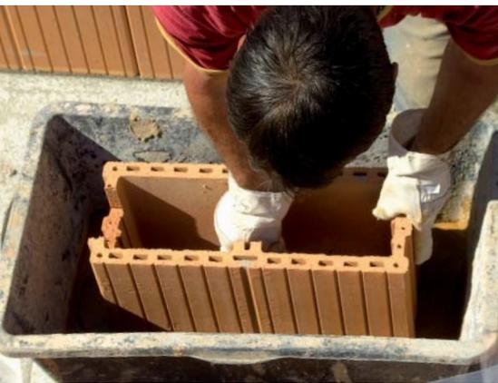
Der Mörtel wird durch Tauchen des Ziegels aufgetragen
