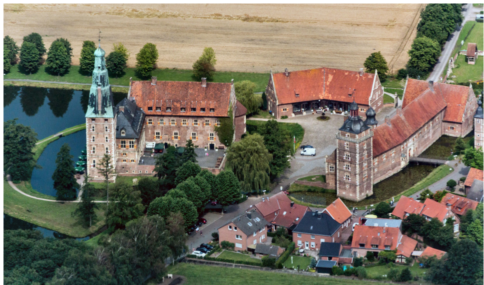
Luftbild der Schlossanlage aus nordöstlicher Richtung (2014)
