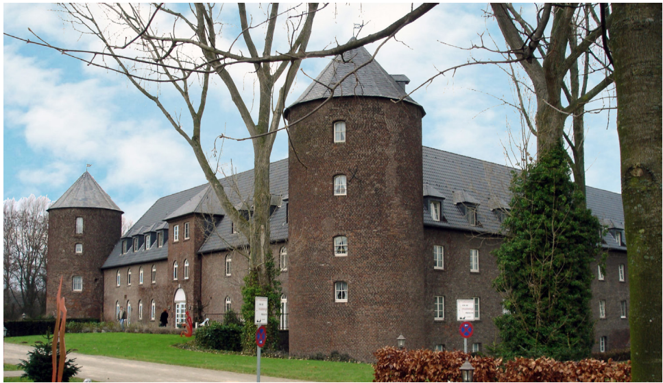
Südansicht der Kernburg von Haus Winnenthal (2005)
