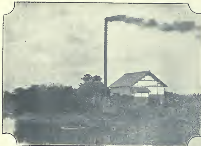
茨城縣稻敷郡源清田村地方ハ利根川ニ瀕シ土地低濕一朝霖雨アレハ直チ 二浸水ノ害ヲ蒙リ洪水忽チ尺余ニ達シテ一大湖狀ヲ呈シ數旬ニ彌ルモ減 水セス爲ニ耕地ノ作毛ナシテ腐蝕ニ歸セシムルノ止ムヲ得サルモノアル ナ以テ惡水ノ排除ト耕地ノ整理ヲ目的トシ排水濾罐ヲ設備セリ面シテ三 十八年水災ノ際ノ如キ該濾罐ヲ使用セシニ僅ニ二晝夜ナラスシテ數百町 歩洪水ヲ全然排除シ多大ノ物產ヲ救メ 茨城縣稻敷郡源清田村地方ハ利根川ニ瀕シ土地低濕一朝霖雨アレハ直チ 二浸水ノ害ヲ蒙リ洪水忽チ尺余ニ達シテ一大湖狀ヲ呈シ數旬ニ彌ルモ減 水セス爲ニ耕地ノ作毛ナシテ腐蝕ニ歸セシムルノ止ムヲ得サルモノアル ナ以テ惡水ノ排除ト耕地ノ整理ヲ目的トシ排水濾罐ヲ設備セリ面シテ三 十八年水災ノ際ノ如キ該濾罐ヲ使用セシニ僅ニ二晝夜ナラスシテ數百町 歩洪水ヲ全然排除シ多大ノ物產ヲ救メ 口 水 排 上 全 The Ingress-End of the Draining Apparatus at the Replotted Tillage-Land of Genseida Village Inashiki District, Ibaraki Prefecture.
