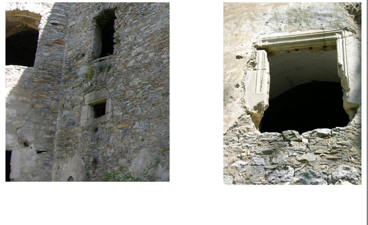
*Bild 31: Baunaht in Position 4*
