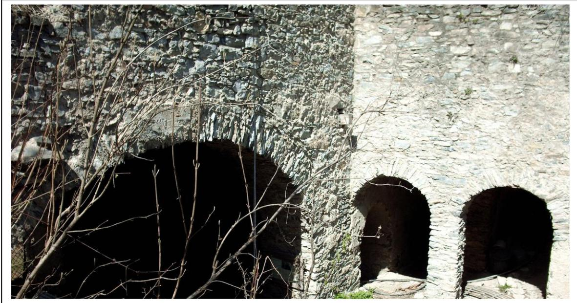
*Bild 30: Baunähte in Positionen 3 und 5 (Spätgotische Profilierungen im älteren Mauerwerk)*
