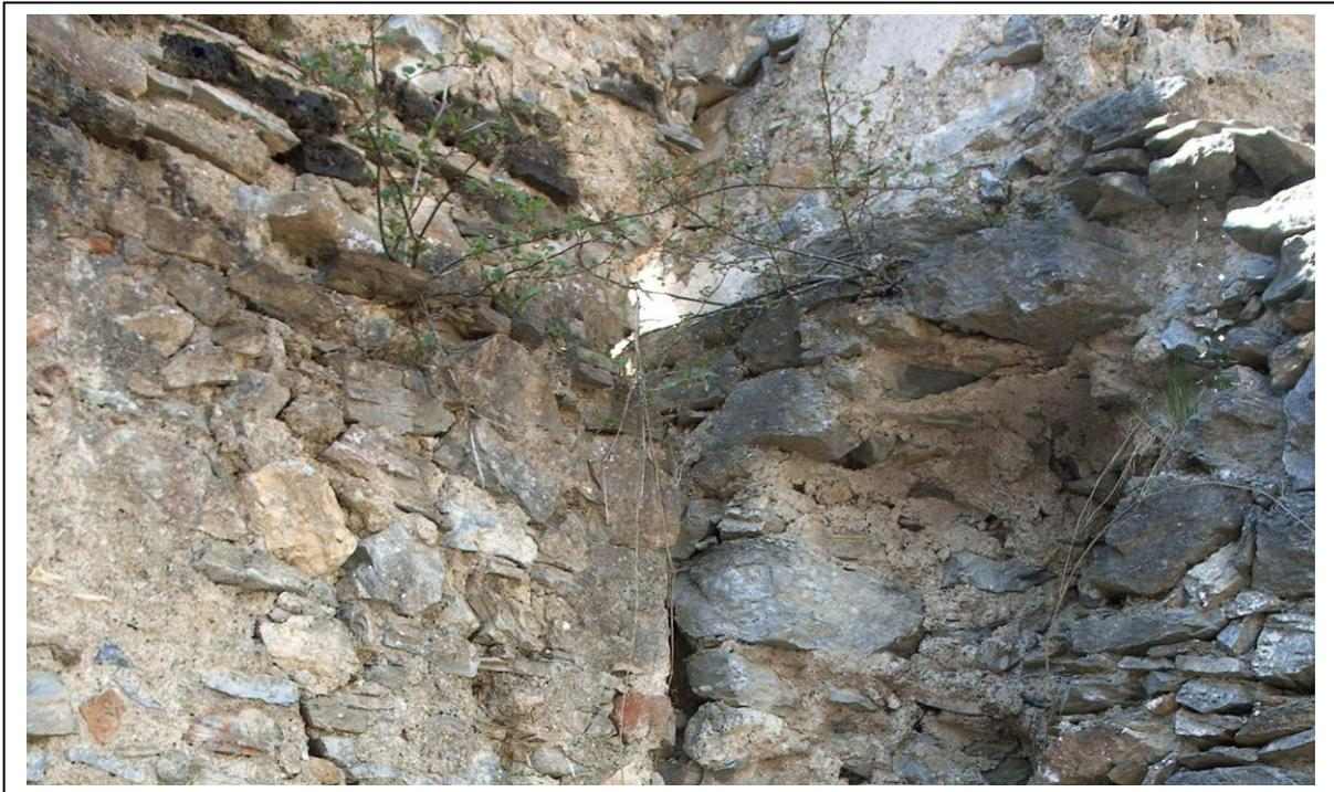
*Bild 29: Baunaht in Position 2*
