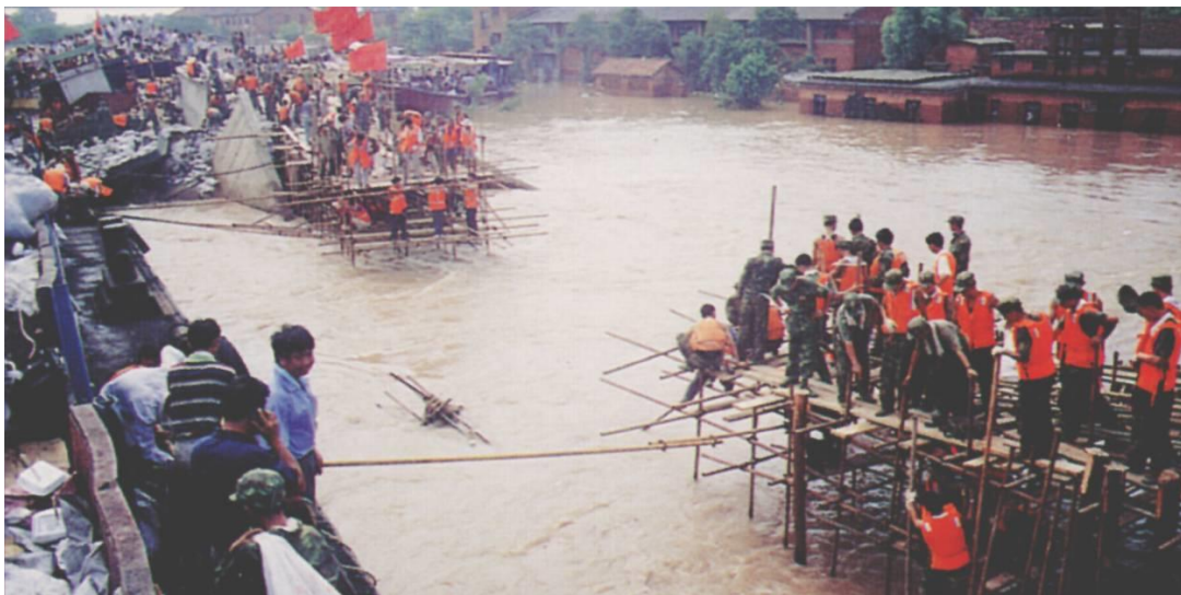
Abbildung 28: Foto von der Deichbruchschließung [IWHR]
