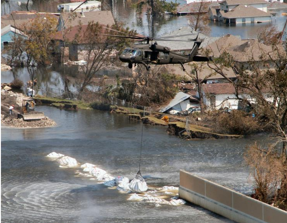
Abbildung 16: Absetzen von BigBags im Deichbruch 17th Street New Orleans (2005) [2]
