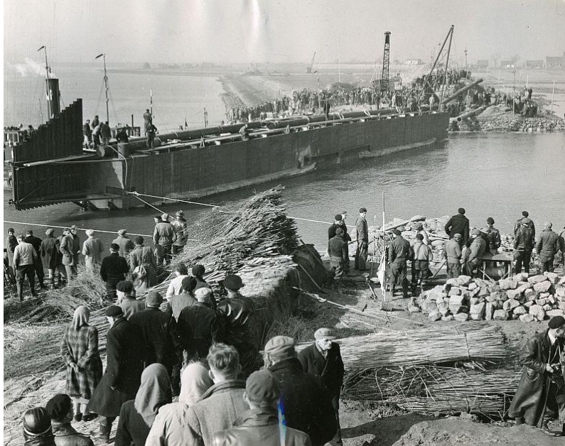
Abbildung 21: Deichschließung durch einen Senkkasten nahe Oudenhorn 26Februar 1953 [Förster]
