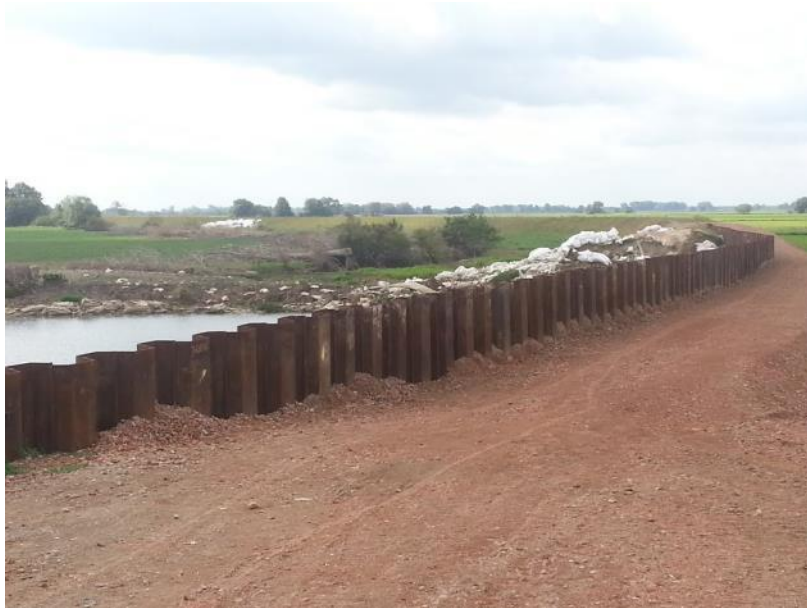
Abbildung 22: Provisorische Spundwand nach dem Deichbruch 2013 in Fischbeck [3]
