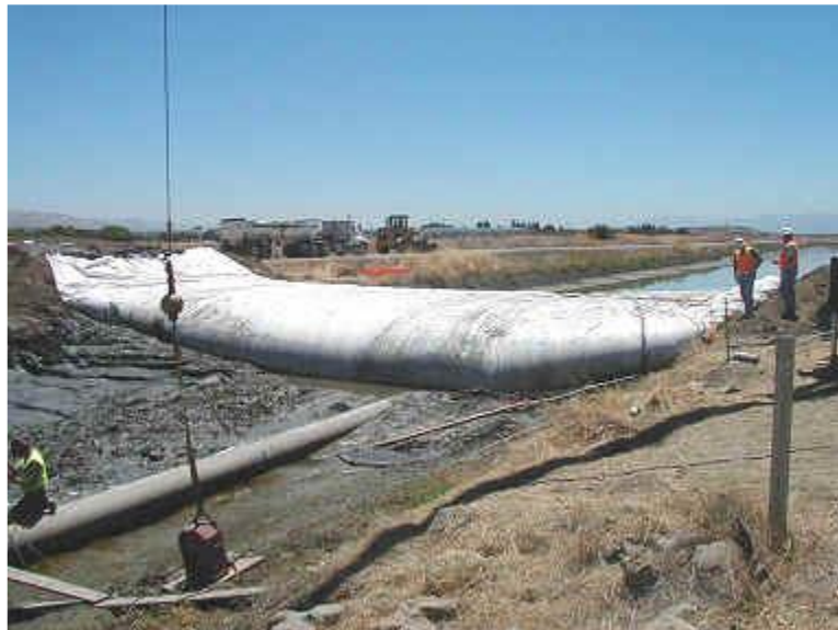
Abbildung 31: An beiden Enden geöffneter AquaDam® [Förster]
