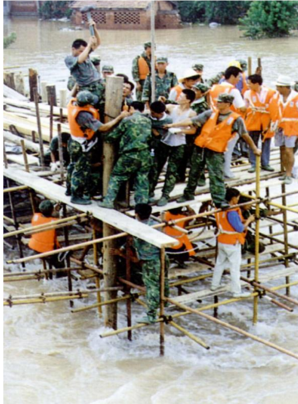
Abbildung 40: Einrammen der Holz-und Stahlstangen in die Bruchstelle durch Handarbeit der Arbeitskräfte [Förster]
