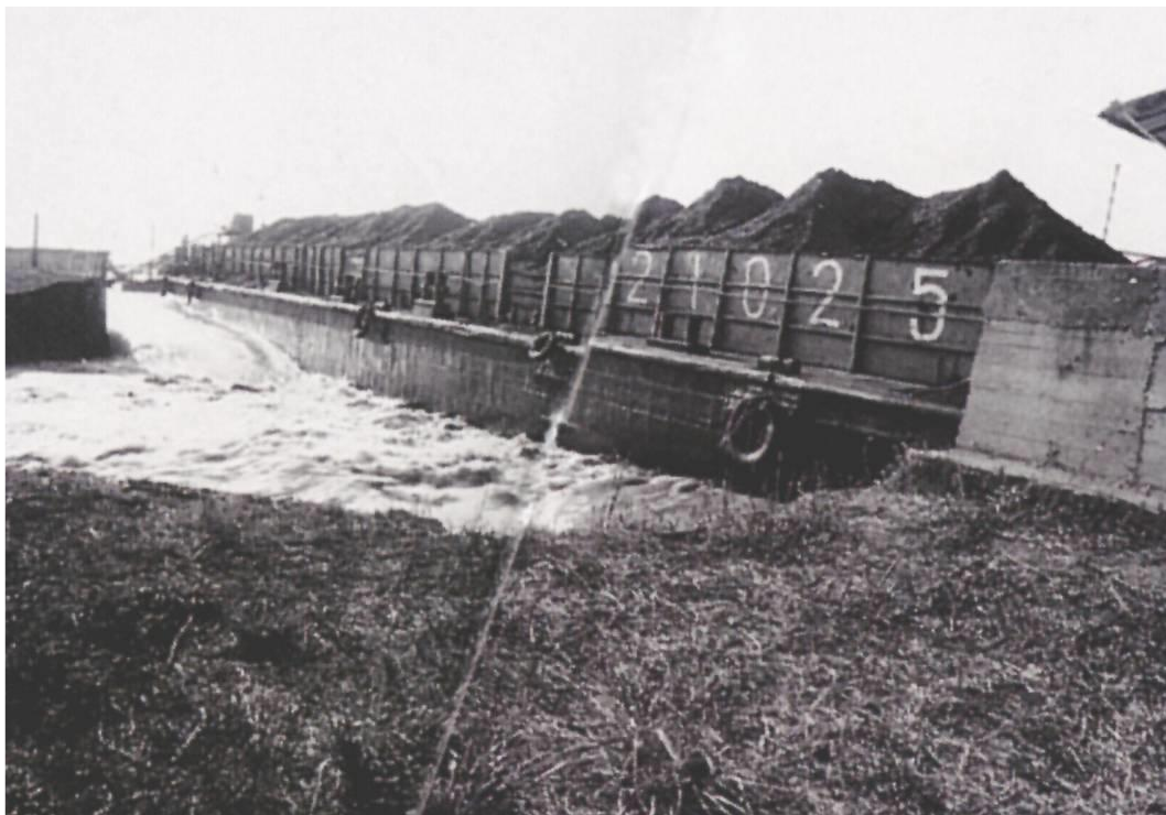
Abbildung 37: Deichbruchschließung mittels Lastkahn [IWHR]
