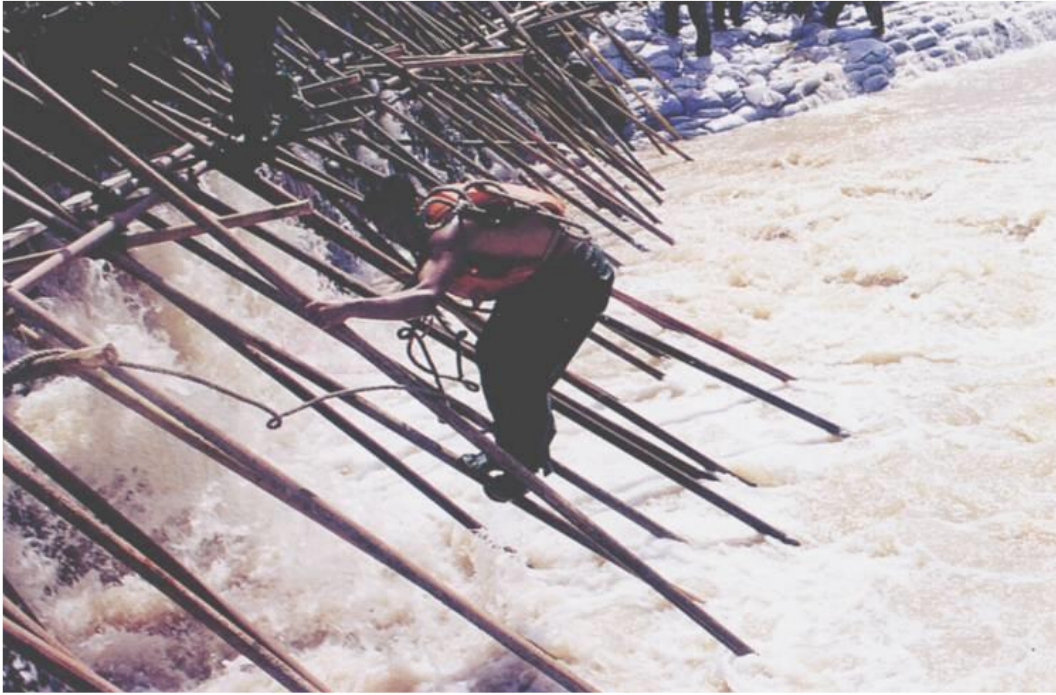
Abbildung 38: Sicherung der Arbeitskräfte mit Seilen [IWHR]
