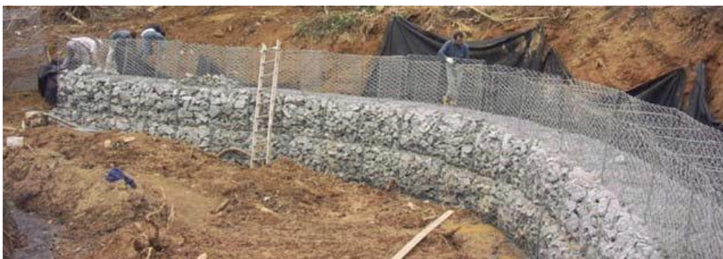
Abbildung 18: In-Situ hergestellte Gabionen auf trockenem Land [Joore]
