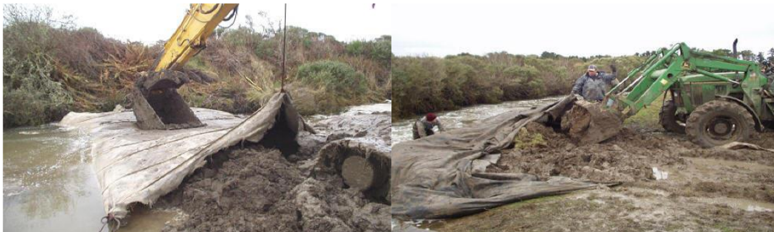
Abbildung 45: Unterbau des AquaDams®
