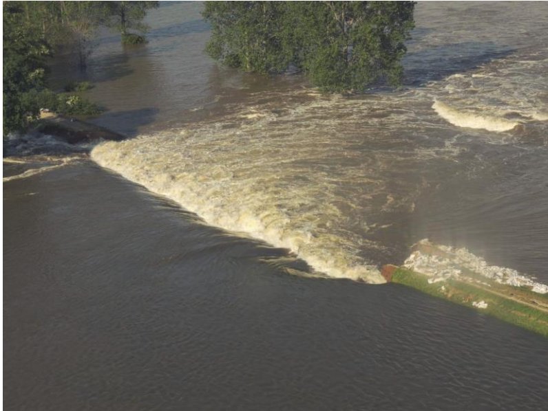
Abbildung 10: Deichbruch bei Fischbeck, Junihochwasser 2013 [LHW]
