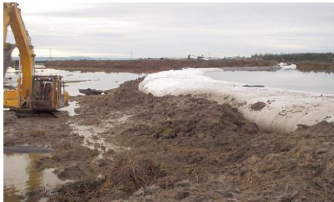
Abbildung 48: Stabilisierung des AquaDam®
