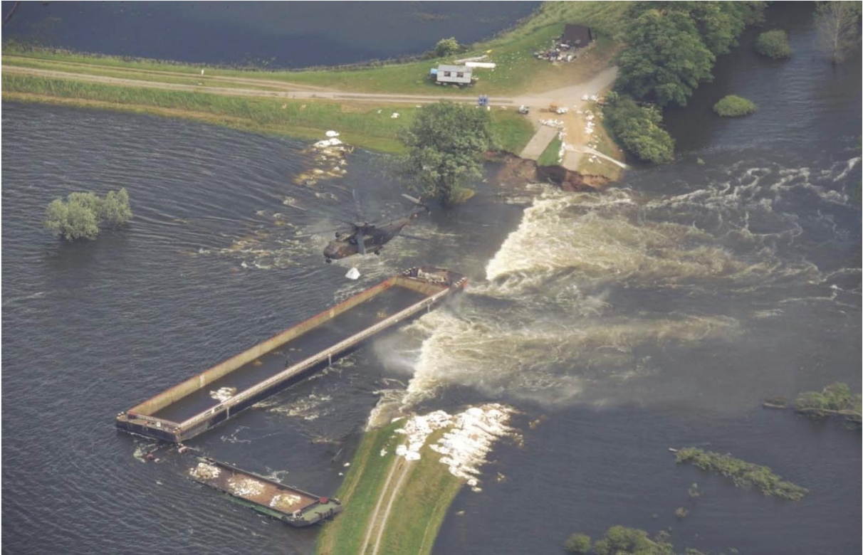
Abbildung 24: Deichbruch bei Fischbeck während des Versuches der Breschenschließung [LHW]
