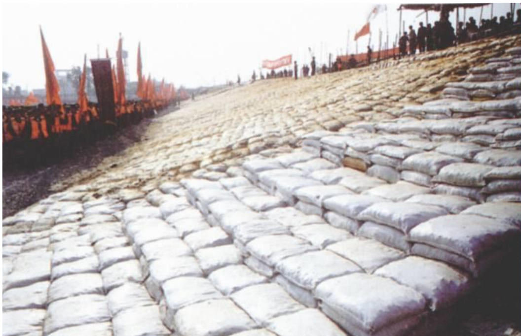
Abbildung 41: Sicherung des Notfallverschlusses mit Sandsäcken [IWHR]
