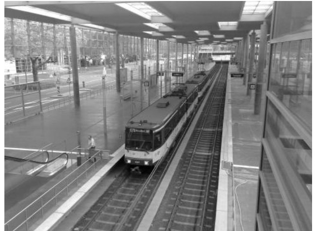
Hochflur-Stadtbahn: Station Arena / Messe-Nord
