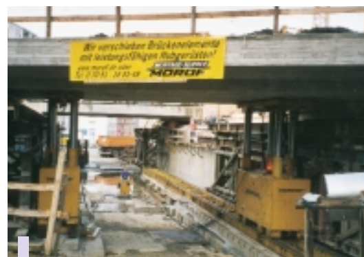
J&R TLS 600 Geräte im Einsatz bei Brückenarbeiten.
