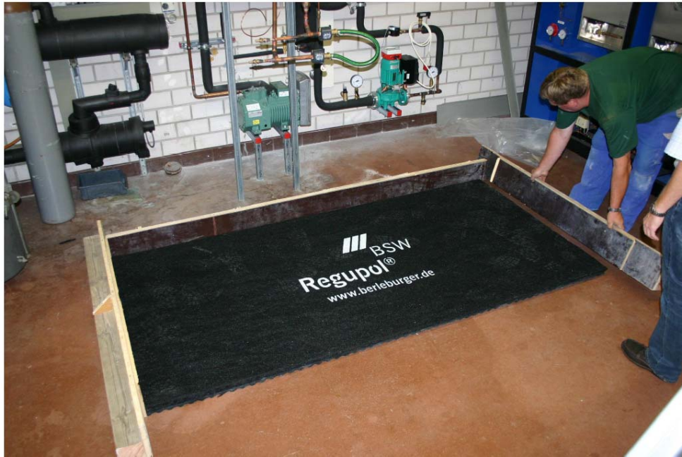
Abbildung 5–18: Guss der Betonplatte (Zuschneiden der Gummiplatte)
