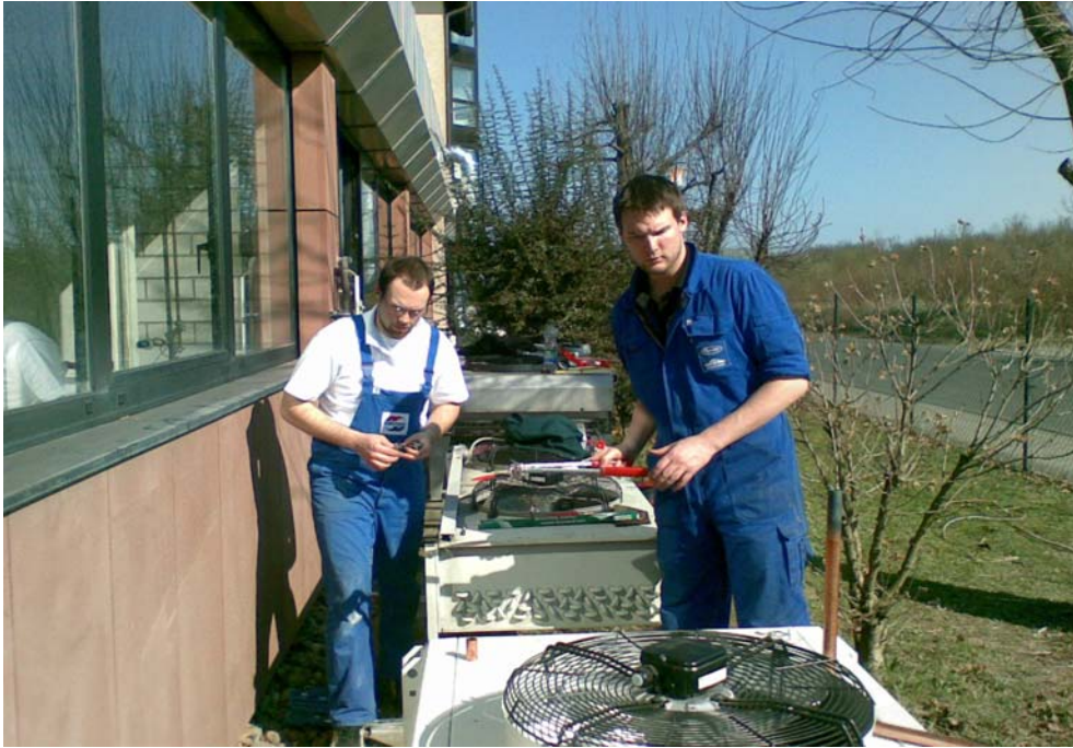
Abbildung 5–4: Anschließen des Verflüssigers
