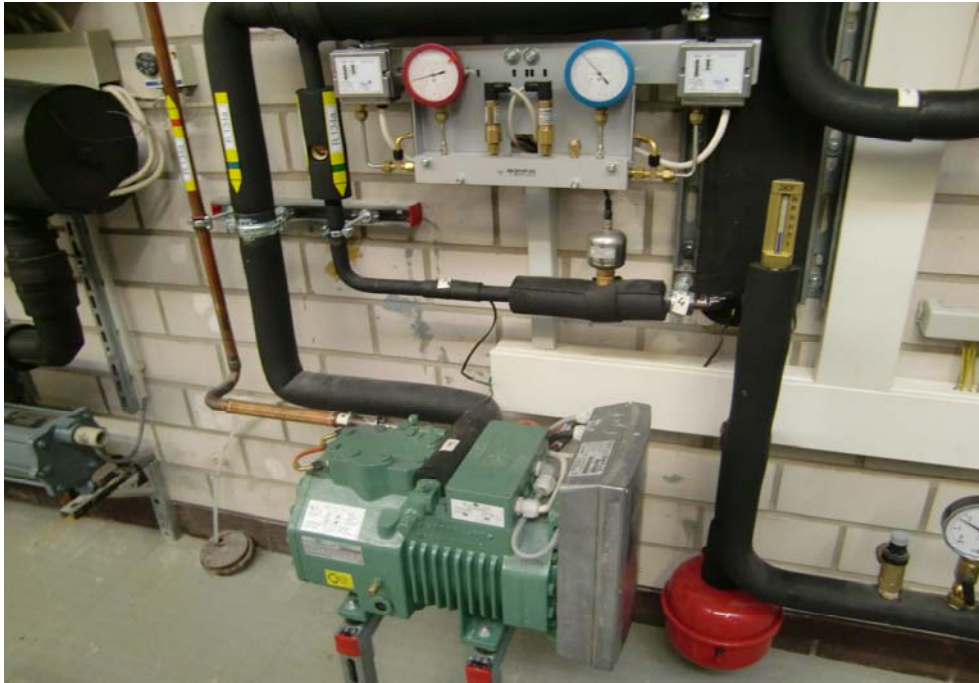
Abbildung 5–22: Verdichter mit Instrumententafel
