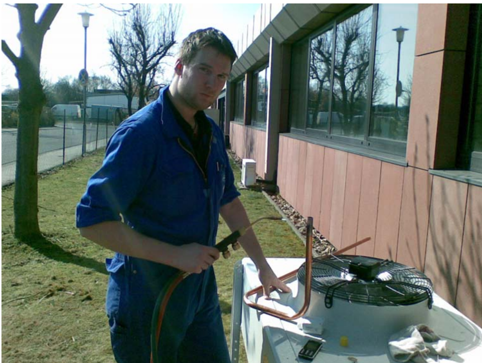
Abbildung 5–5: Anschließen des Verflüssigers 2
