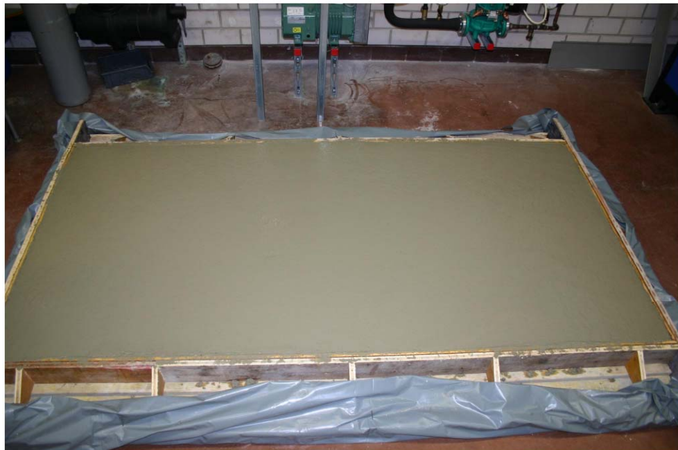
Abbildung 5–21: Guss der Betonplatte (fertig abgezogen)
