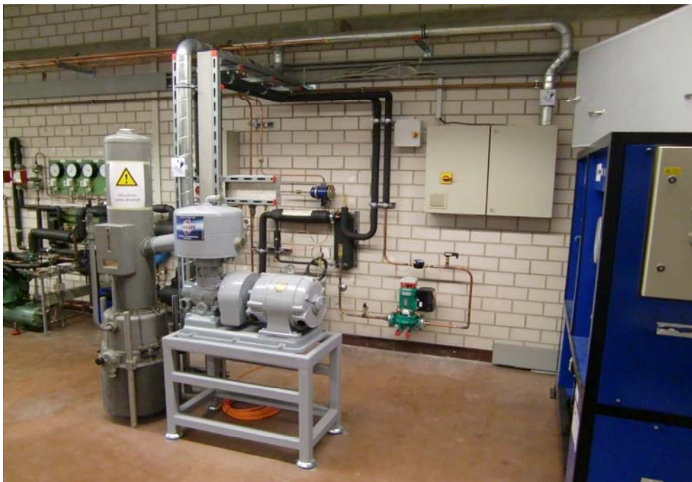
Abbildung 5–9: Gesamtanlage im Aufbau
