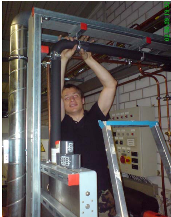
Abbildung 5–17: Verlegung und Dämmung des Rohrsystems
