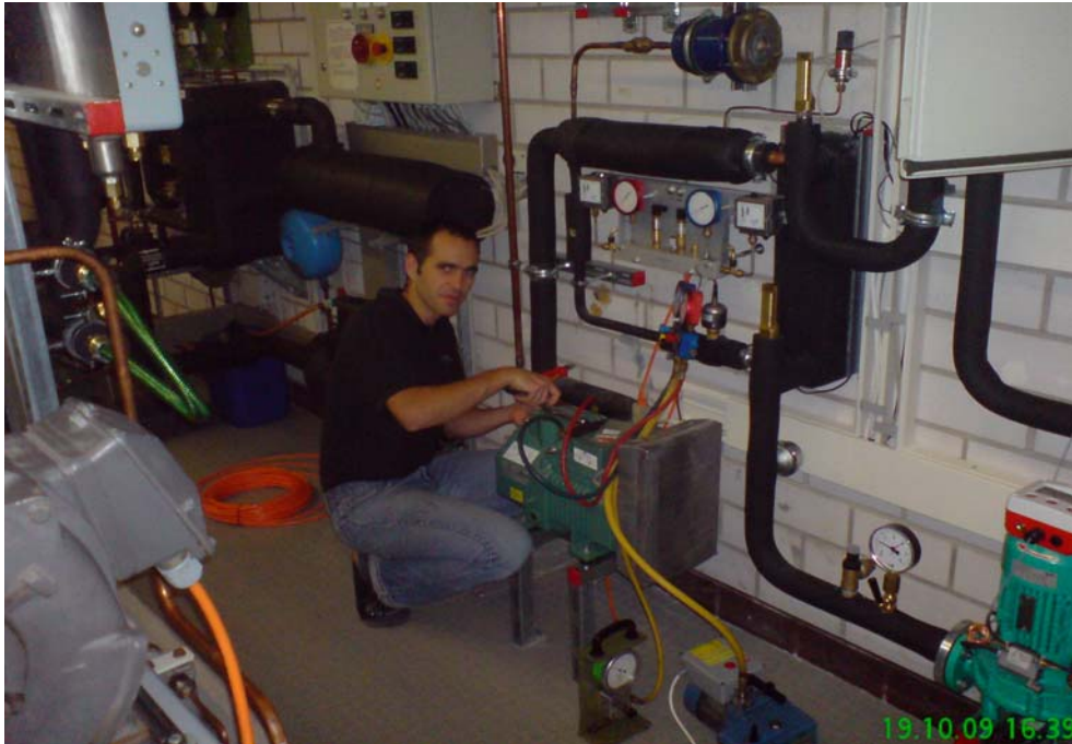
Abbildung 5–8: Evakuierung des Systems
