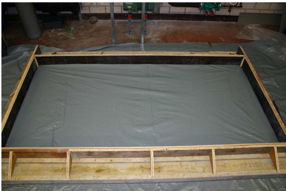
Abbildung 5–19: Guss der Betonplatte (Schalung mit PE Folie)
