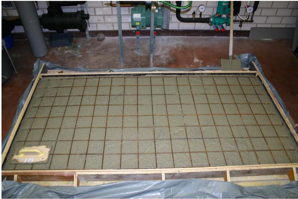
Abbildung 5–20: Guss der Betonplatte (Beton mit Drahtmatte)
