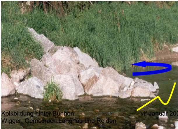
Kolkbildung hinter überströmbarer Schwelle Wigger, Gemeinden Langnau und Reiden vif Januar 2002
