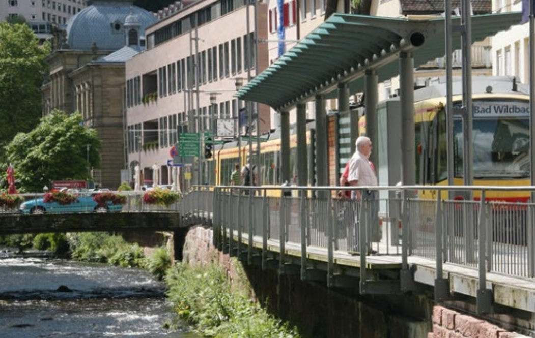
Bad Wildbad: Die Verlängerung einer Stadtbahnlinie in beengter Zentrumslage wurde anspruchsvoll umgesetzt und die Innenstadt damit nachhaltig revitalisiert. (Foto: LBBW Immobilien Kommunalentwicklung GmbH)
