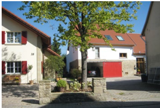
Umnutzung einer leer stehenden Scheune zu Wohnraum und Schließung einer innerörtlichen Baulücke durch einen maßstäblichen Neubau (Fotos: Ulrike May-Schorb)
