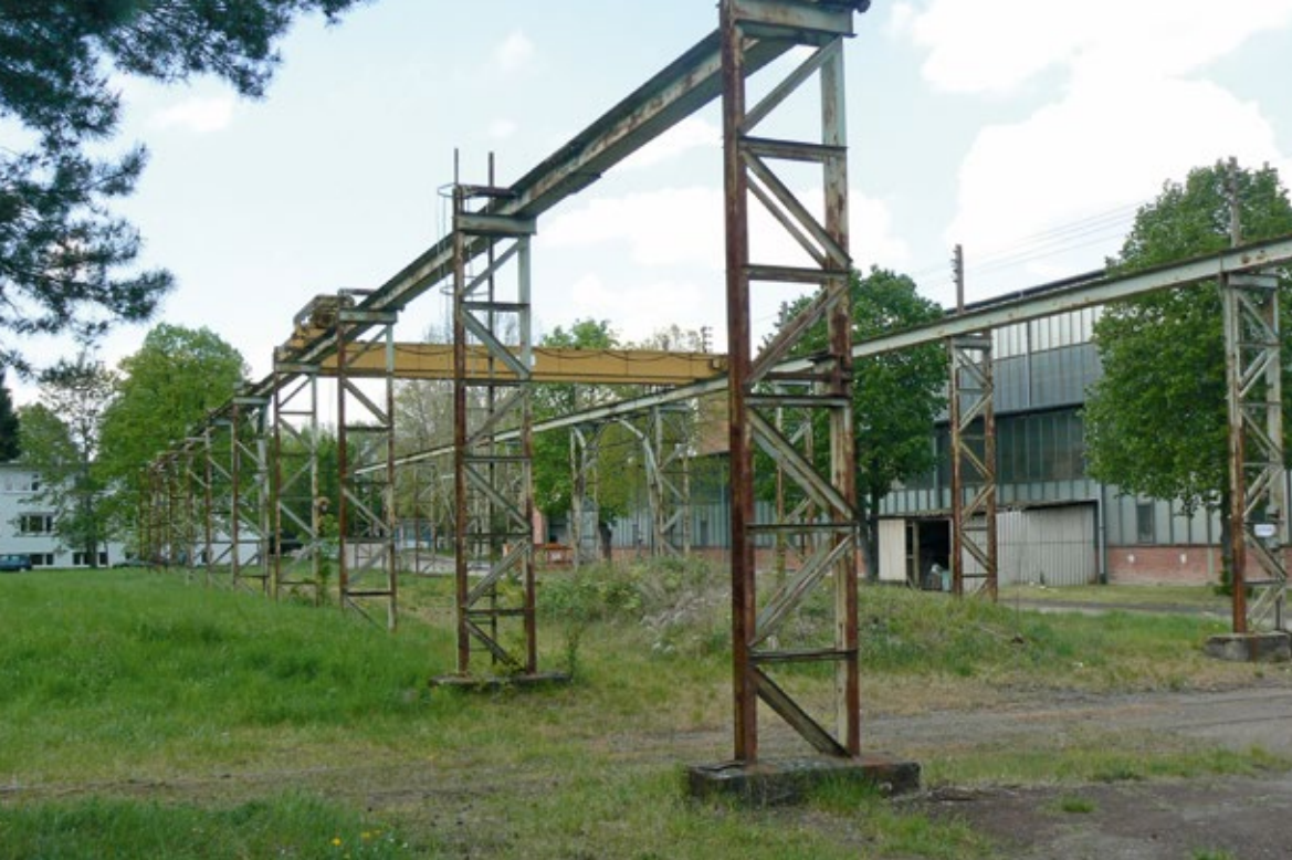
Ehemalige Maschinenfabrik bei Karlsruhe (Quelle: Re2area GmbH, Heidelberg)
