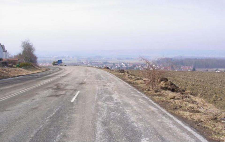
Die alte B30 bei Baindt (Landkreis Ravensburg) hat ausgedient
