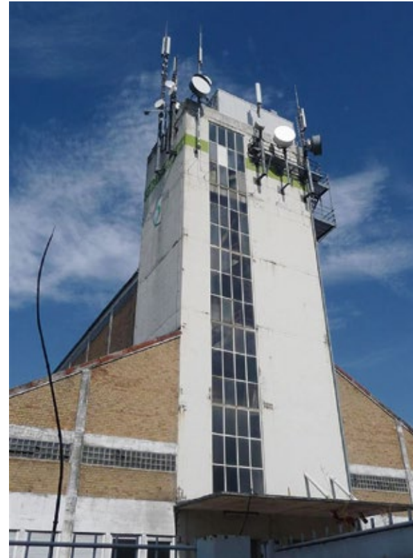
Silo-Turm mit Funkantennen in einem Wohngebiet bei Mannheim (Quelle: Re2area GmbH, Heidelberg)
