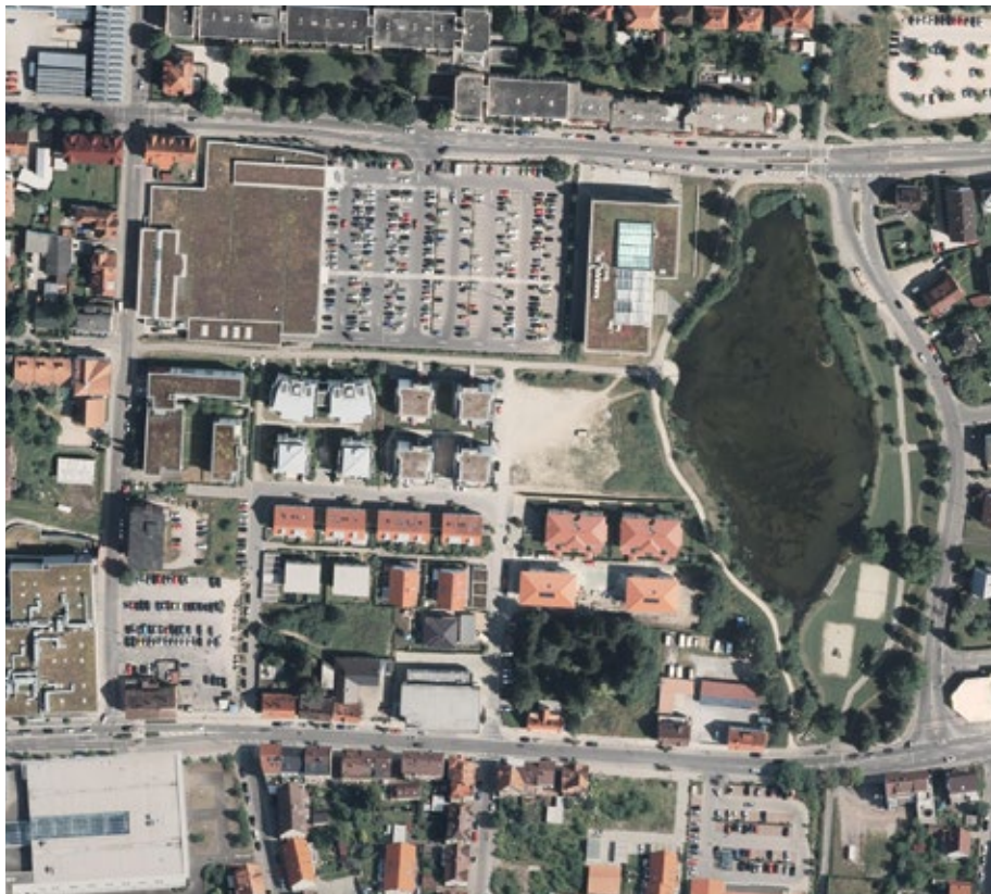
Kienzle-Areal vor und nach der Sanierung und Umnutzung (Quelle: Landesamt für Geoinformation und Landentwicklung Baden-Württemberg)
