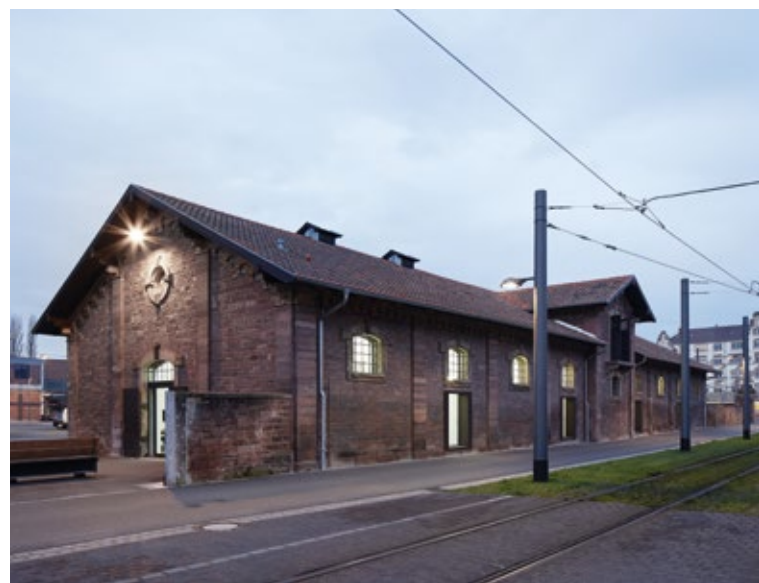
Umbau eines ehemaligen Schweinestalls zum Büro, Karlsruhe, Architekt: Matthias Tebbert, zwolf, Büro für Gestaltung, Karlsruhe, Bauherr: Karlsruher Fächer GmbH + Co. Stadtentwicklungs-KG (Foto: Stephan Baumann)
