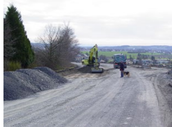
Der Rückbau macht Fortschritte
