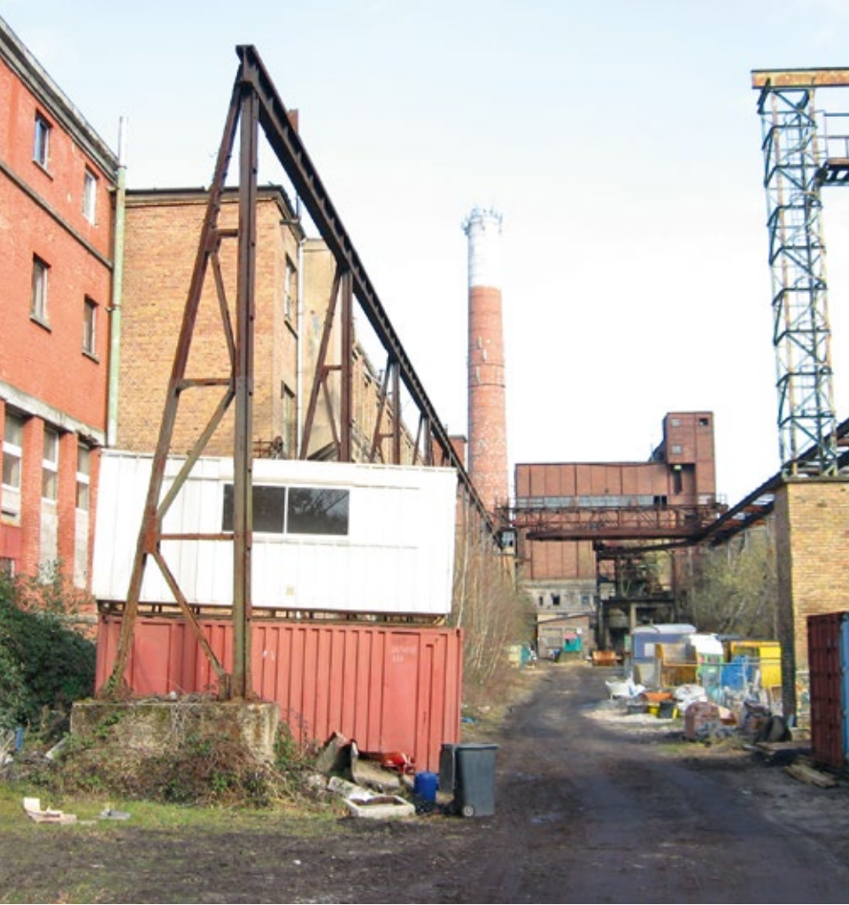
Industriearreal mit Restnutzungen (Quelle: Re2area GmbH, Heidelberg)
