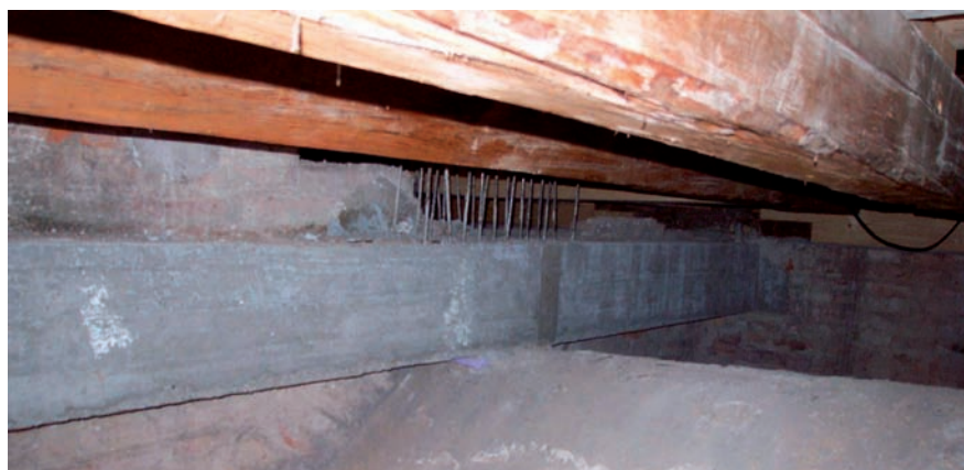
Abb. 28: Blick auf die neuen Stahlbetonbalken seitlich der Übermauerung über dem Gewölbescheitel des äußeren nördlichen Seitenschiffes
