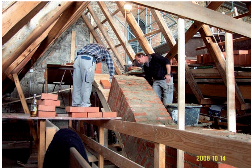
Abb. 26: Rekonstruktion eines Strebebogens (hier: Südseite) nach Bestandsvorbild
