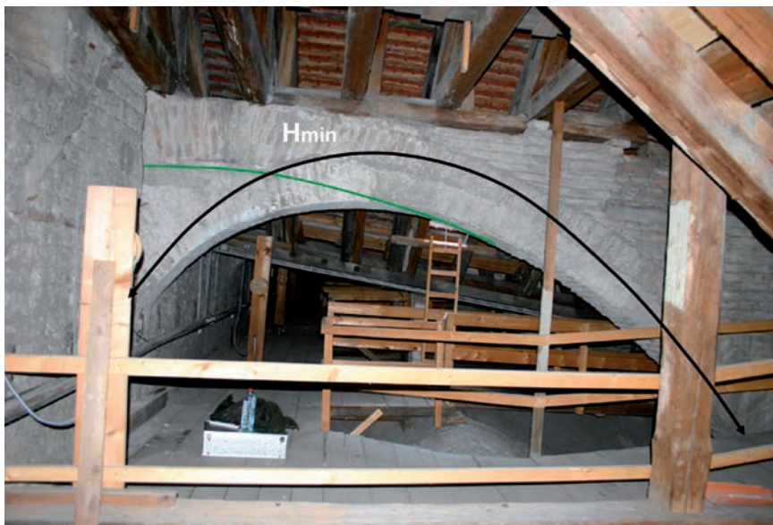
Abb. 24: Strebebogen der Südseite, Stützlinienverlauf mit minimalem Horizontalschub unter Berücksichtigung der Ausrundung
