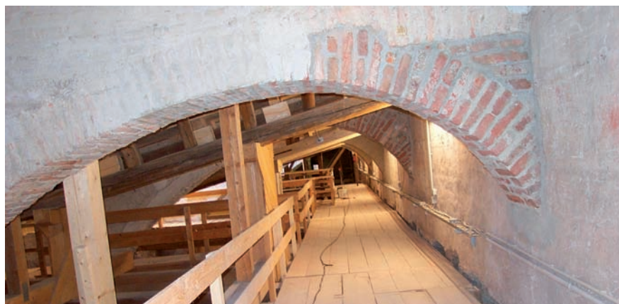
Abb. 27: zusätzlich eingebrachte Ausrundungen am Ansatz an die Hochschiffmauer bei allen Strebebögen der Nordseite
