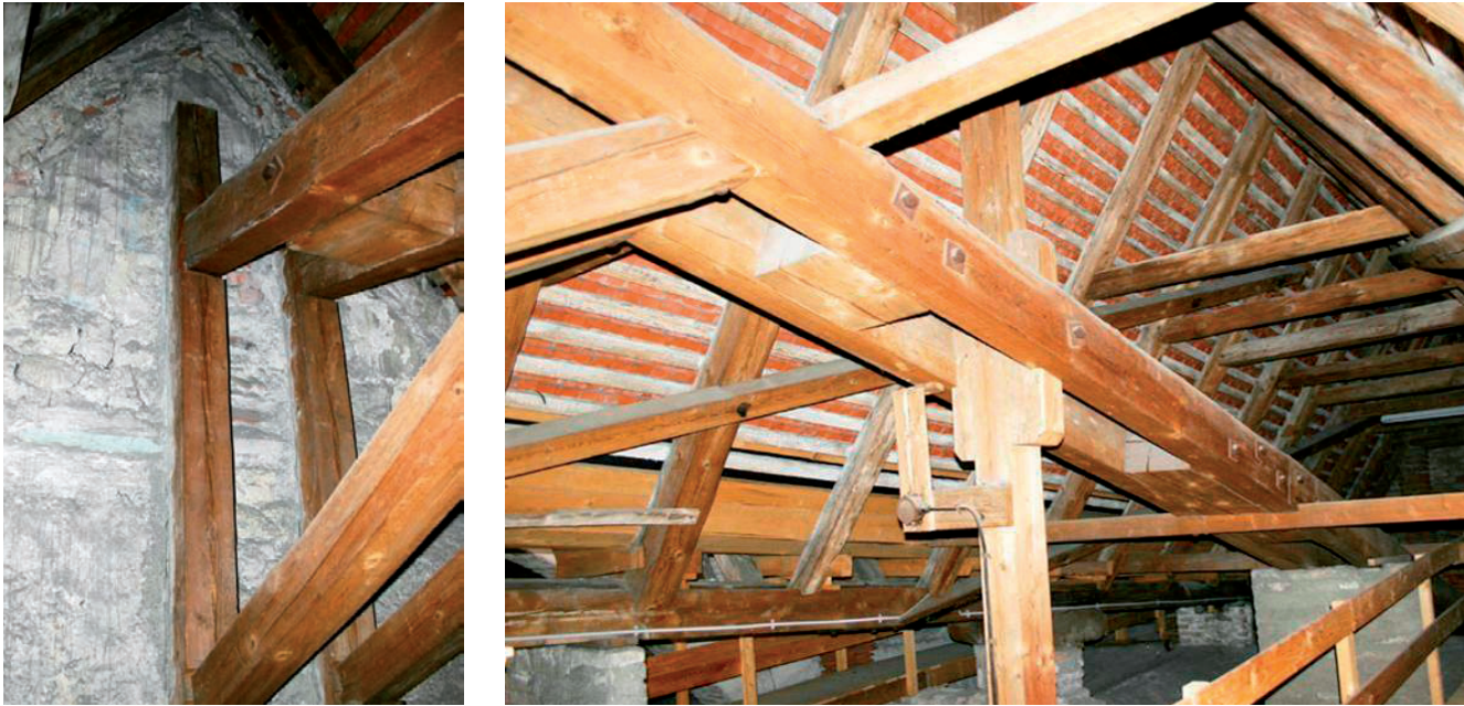
Abb. 11: Hölzerne Stützkonstruktion im südlichen Seitenschiffdach (Achse 6S) als Substitut für den fehlenden Strebebogen
