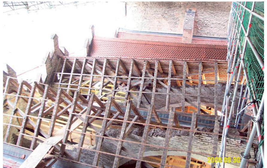
Abb. 4: Blick auf die unter den Pultdächern der Seitenschiffdachwerke verborgenen Strebebögen (hier: Südseite)
