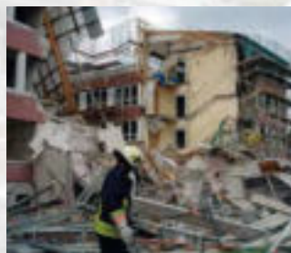
Einsturz eines Gebäudes durch unsachgemäße Bauarbeiten
