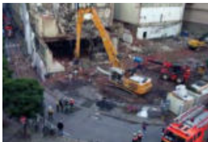
Für notwendige Abbruch- und Aufräumarbeiten möglichst Spezialgerät oder Spezialfirmen hinzuziehen.
