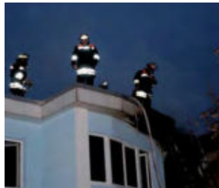
Absturzgefahr an der Kante des Flachdaches
