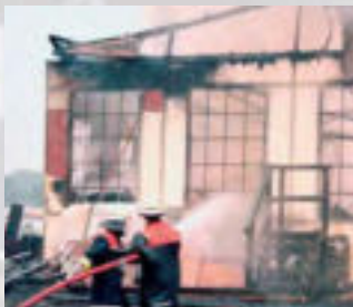
Einsturzgefahr der Fassade durch Brandeinwirkung
