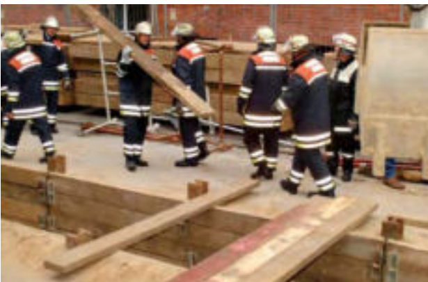
Behelfsmäßiger Übergang aus Bohlen
