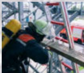
Sicherung des Leiterkopfes gegen Abrutschen
