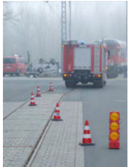
Sperrung einer Fahrspur mit Verkehrsleitkegeln und Warnleuchten
