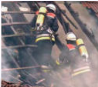
Durchbruchgefahr! Unsicherer Stand auf angebrannten Dachlatten
