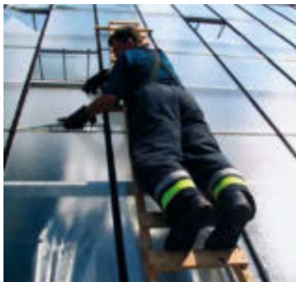
Beschädigte Glasscheiben eines Gewächshauses werden nach Beschädigung durch Hagelschlag vorsichtig entfernt (Feuerwehrlinien und Schutzjacke wurden auf Grund großer Hitze abgelegt).
