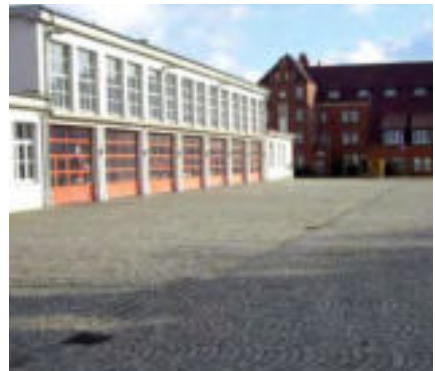
Der Stauraum vor den Toren bringt Sicherheit.
