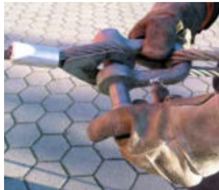
Zugseile und Anschlagseile nur mittels Schäkel verbinden.
