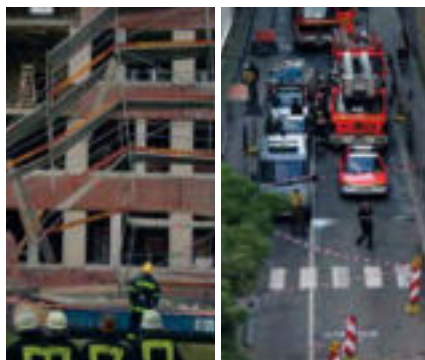
Der Gefahrenbereich ist auch für Einsatzkräfte abgesperrt.
