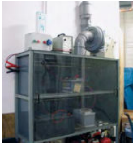
Platz sparende Alternative – Schrank zur Batterieladung mit Absaugung
