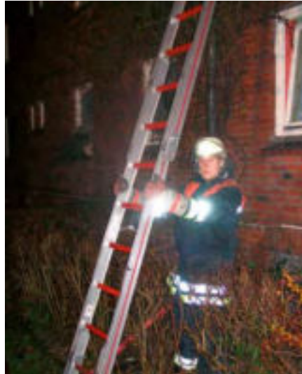
Sicherung der Leiter gegen Umstürzen
