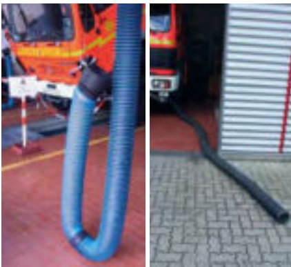
Abgasabsaugung im Werkstattbereich
