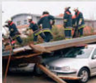
Einsturz durch Überlastung der Carport-Konstruktion
