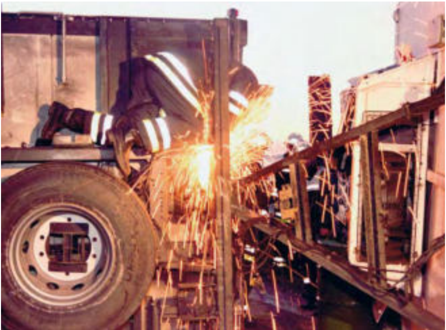
Brennschneiden unter erschwerten Bedingungen nach einem LKW-Unfall
