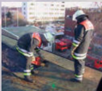
Durchbruch- und Absturzgefahr! Einsatzmaßnahmen auf unsicherer Standfläche unmittelbar an der Absturzkante des Flachdaches
