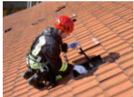
Arbeiten auf Dächern
