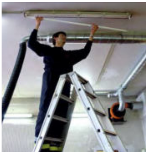
Typische Instandhaltungsarbeit: Auswechseln einer Leuchtstoffröhre mit Hilfe einer Stehleiter
