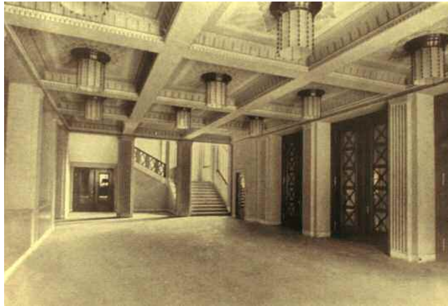
Eindrucksvolle Architektur im Eingangsbereich des neuen Vereinshauses.
