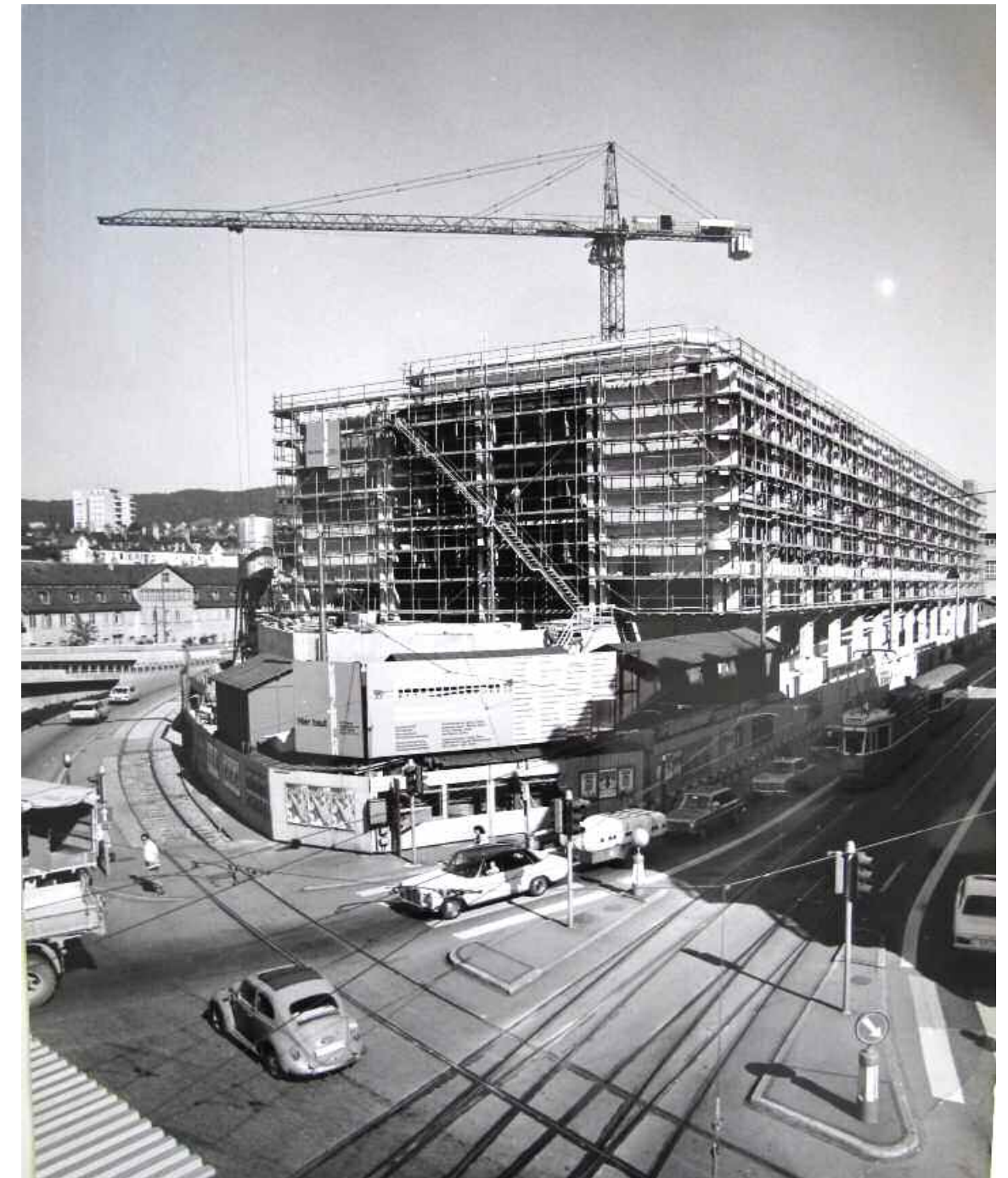
Die neue Berufsschule des KVZ im Rohbau; eine moderne Bildungsstätte mit hundert Unterrichtszimmern, Turnhalle, Schwimmbad und vielen Nebenräumen.
