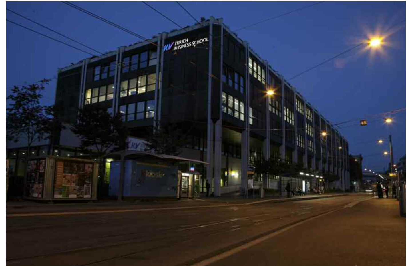
Supertanker der Berufsbildung: Das Hauptgebäude KV Zürich Business School ist in den letzten Jahren baulich und energetisch saniert worden.
