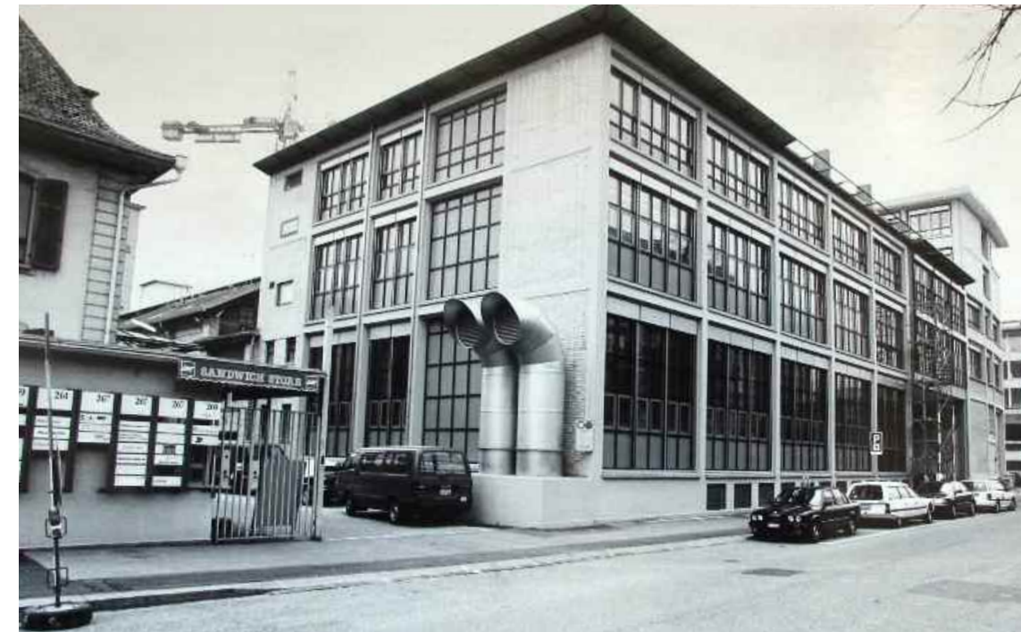
In der ehemaligen Waschmittelfabrik Steinfels beim Escher Wyss Platz entstehen neue Schulräume der KV Zürich Business School.
