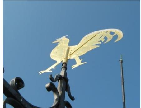
Reinigung der Oberfläche, Grundierung und Lackierung im gelben Vorlegeton, Auftrag von Mixtinon als Goldklebemittel, Anschließen und Einkehren des Blattgoldes als Sturm- und Wettervergoldung.
