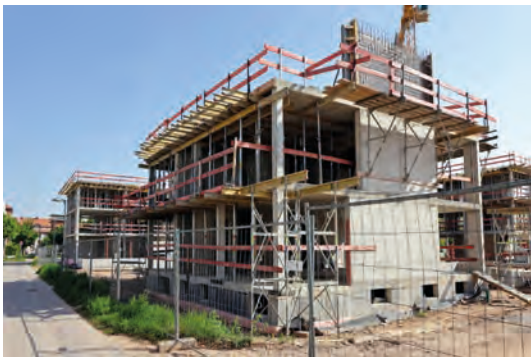
Baufeld 15, 2022 © Norman P. Krauß, Landau in der Pfalz
