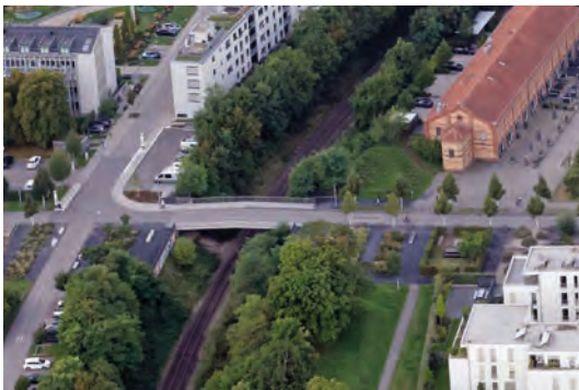
Brücke Süd © Norman P. Krauß, Landau in der Pfalz
