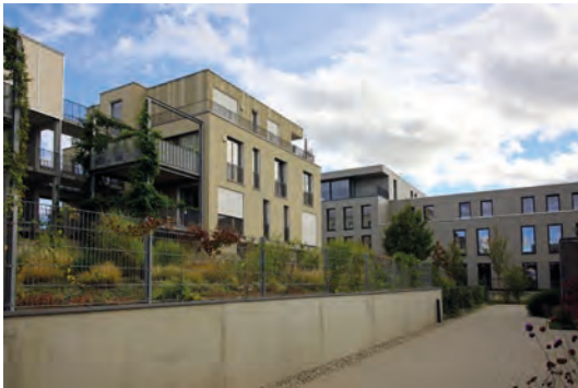
Baufeld 17 © Norman P. Krauß, Landau in der Pfalz
