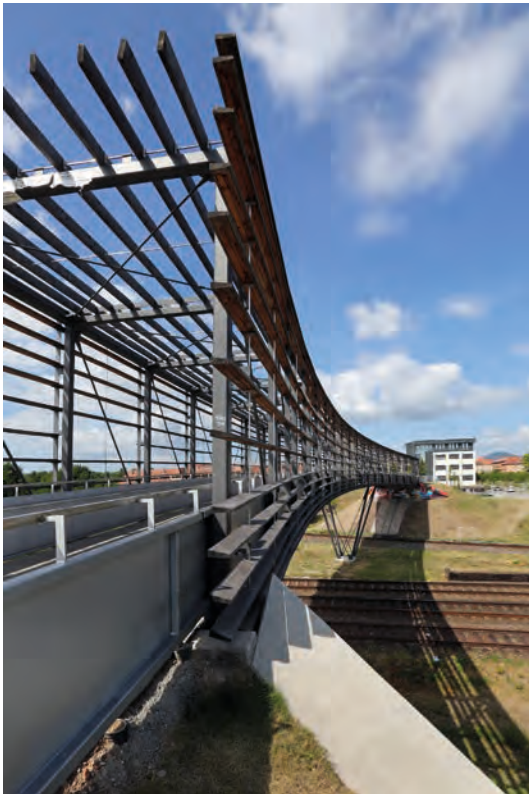
Fuß- und Radbrücke Ost © Norman P. Krauß, Landau in der Pfalz
