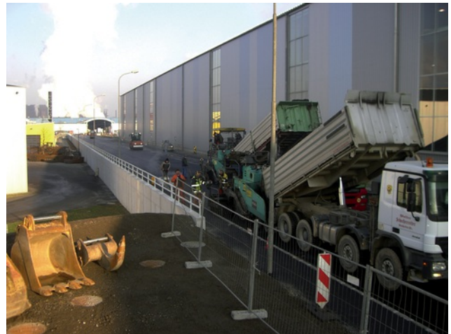
Fertige Stützmauer Bild: PORR
