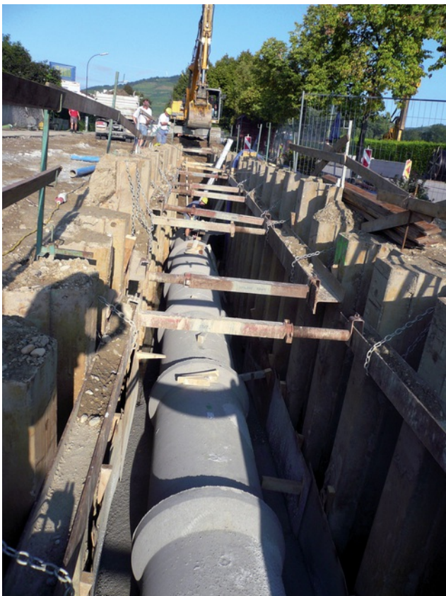
Künette mit Spundwänden und Unterwasserbetonplombe für Rohrverlegung im Grundwasser Bild: PORR
