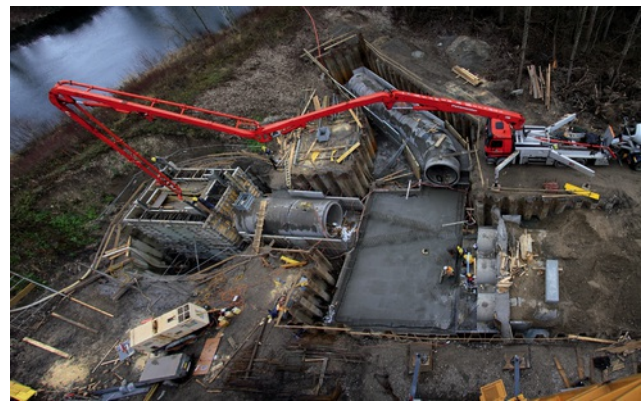
Dükerbauwerk und Verteilbauwerk Bild: PORR
