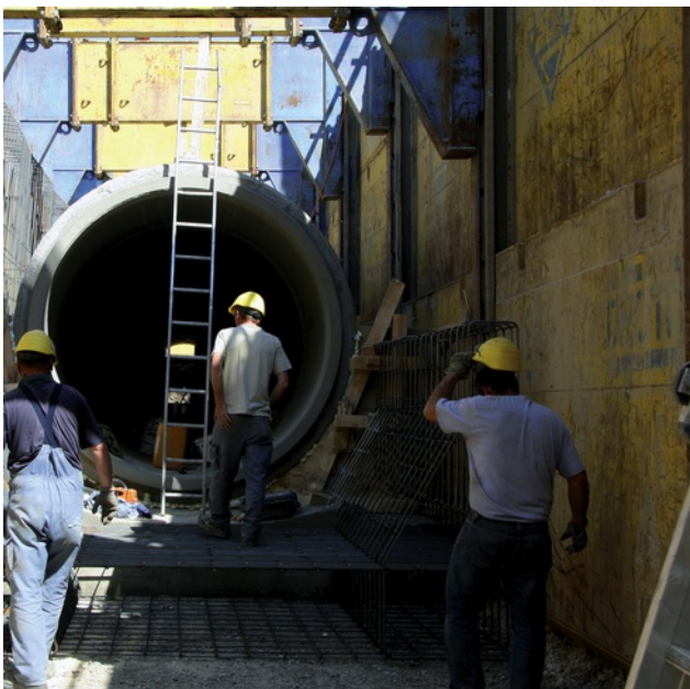
Regelquerschnitt DN2400 in MEGA-Doppelgleitschienenverbau Bild: PORR
