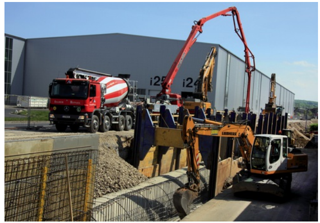
Errichtung der aufgesetzten Stützmauer Bild: PORR
