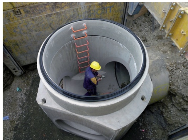
Schachtunterteil DN2000 mit DN1600 Hauptgerinne Bild: PORR
