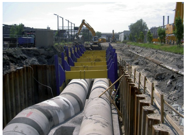
Übergang von einem Spundwand- auf MEGA-Doppelgleitschienenverbau Bild: PORR
