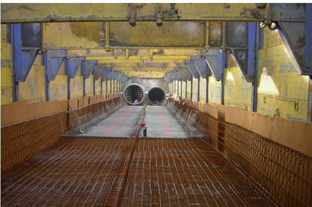
Regelquerschnitt DN2600/DN2200 in MEGA-Doppelgleitschienenverbau Bild: PORR
