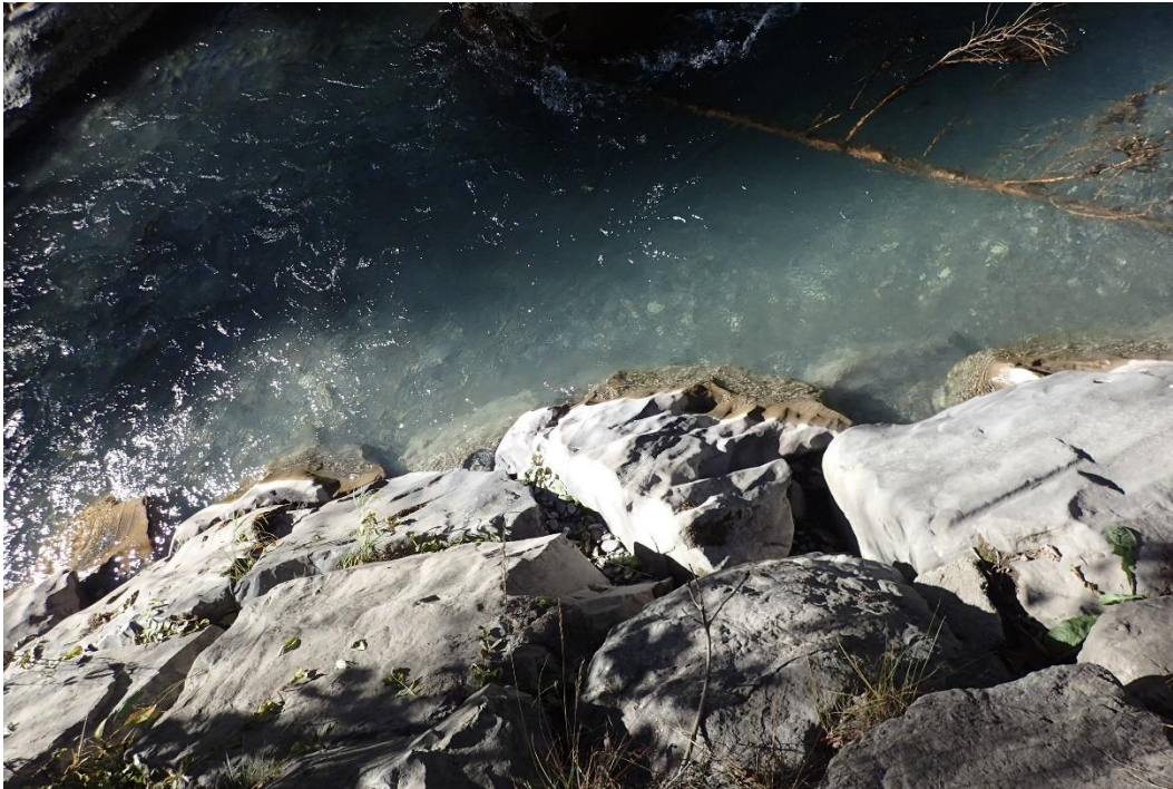
Abbildung 2: Blocksatz unter der Margelibrücke.
