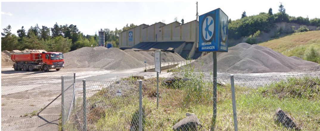
Abbildung 4: Ansicht Einfahrt, Lagerplatz, Pneuwaschanlage, Vorderseite Kies- und Betonwerk mit Silo
