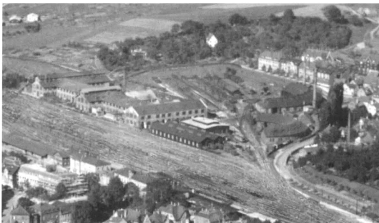
Blick auf das Bahnbetriebswerk Aalen, 1926.
