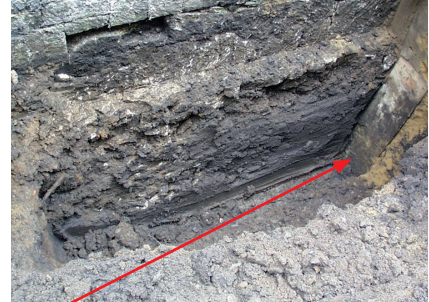
Holzbohle zum Schutz des fertigen Bauabschnittes
