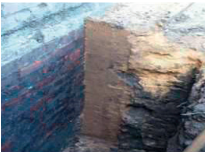
Fertiger Bauabschnitt, Holzbohle entfernt
