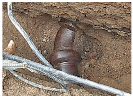
Von Hand verdichtete Rohrdurchführung
