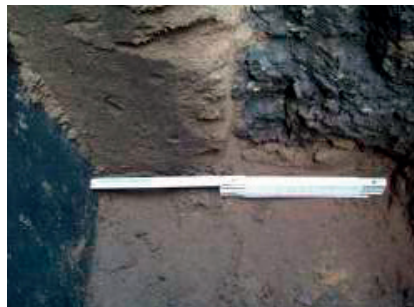
Kontrolle der Einbaustärke von 0,20 m
