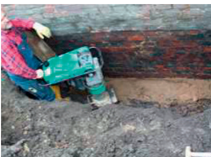
DERNOTON®-Fertigmischung BA und Füllboden werden gleichzeitig verdichtet
