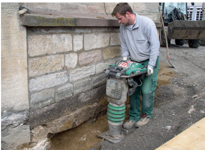
Gleichzeitiges Verdichten der DERNOTON®-Fertigmischung und des Füllbodens nach Entfernen des Trennstreifens
