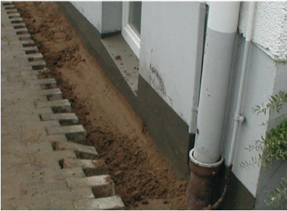
Oberflächenschutz aus Pflastersteinen darunter DERNOTON®-Fertigmischung (verdichtet)
