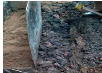
Trennstreifen während des Einfüllens von DERNOTON®-Fertigmischung BA und des Füllbodens
