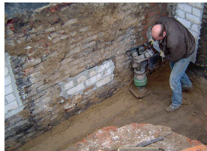
Es muss so oft verdichtet werden, bis ca. 97% Proctordichte erreicht ist.
