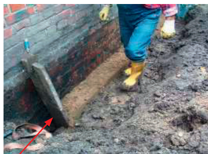
Holzbohle als Begrenzung des zu bearbeitenden Bauabschnittes
