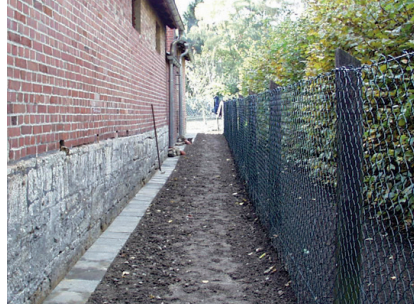
Oberflächenschutz aus Betonplatten
