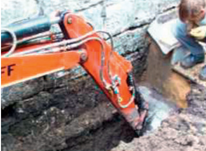
Freilegen des Fundamentes für den nächsten Bauabschnitt
