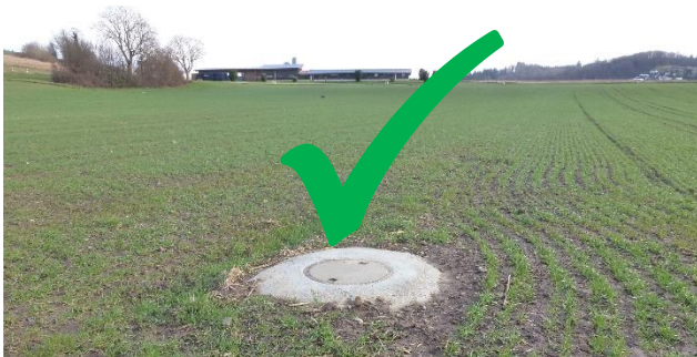
Schächte ohne Entwässerungsfunktion sind mit geschlossenen Deckeln saniert (konforme Situation).
