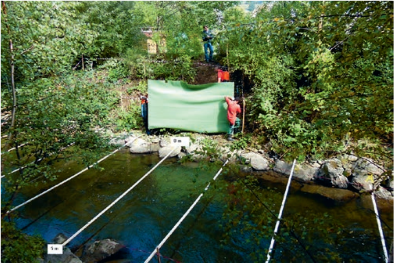
Verwendung der Schutzwand aus Vlies. Sie wandert mit der spritzenden Person mit (im Bild vom Vlies verdeckt), sodass die Auffangwirkung maximal ist.
