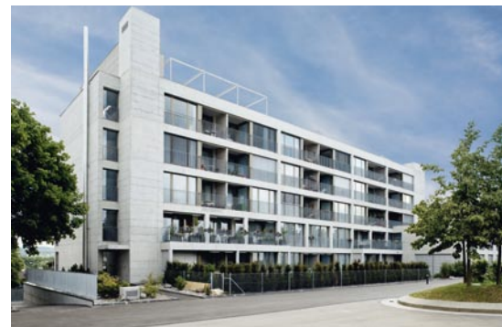
Auf der Südwestseite, die gegen den ruhigen Dorfplatz ausgerichtet ist, besitzt jede Wohnung eine Loggia.
