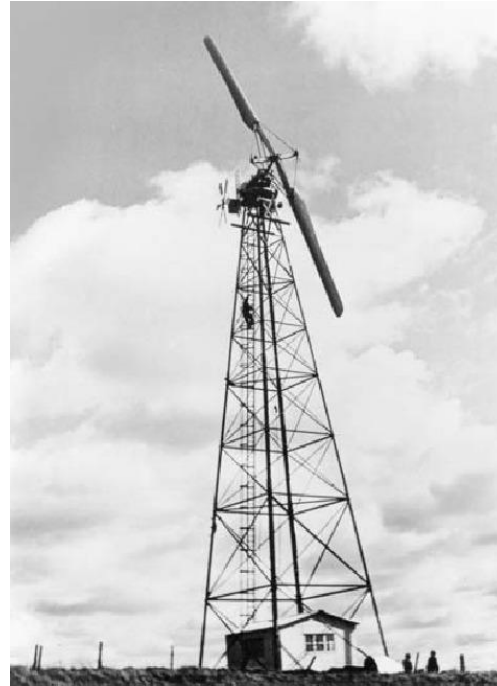
Smidth Aeromotor, mit Stahlfachwerk- und Betonturm 1941/42, P = 50 \text{ kW} , D = 17.5 \text{ m} , 2 Blätter, Schnellaufzahl = 9, Unverwundene, nicht verstellbare Blätter
