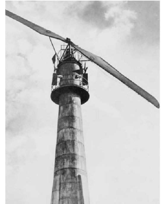
Smidth Aeromotor, mit Stahlfachwerk- und Betonturm 1941/42, P = 50 \text{ kW} , D = 17.5 \text{ m} , 2 Blätter, Schnellaufzahl = 9, Unverwundene, nicht verstellbare Blätter
