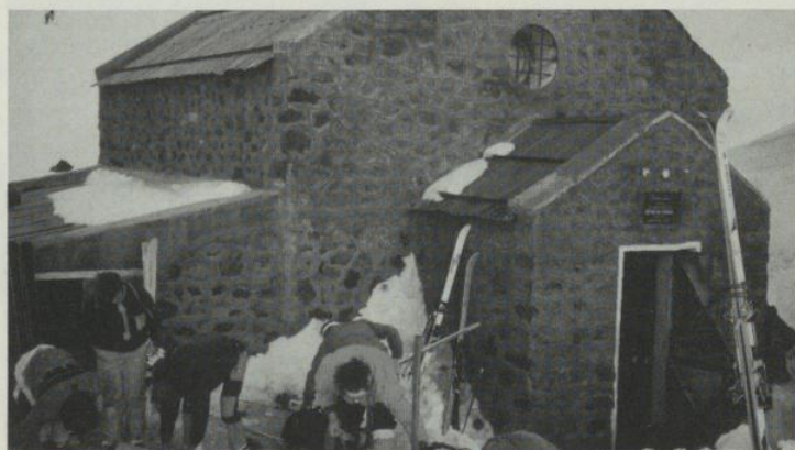
Die auf ca. 3.020 m gelegene Neltherütte in der Toubalkette ist Ausgangspunkt für die Besteigung des Djebel Toubkal, 4.168 m.
