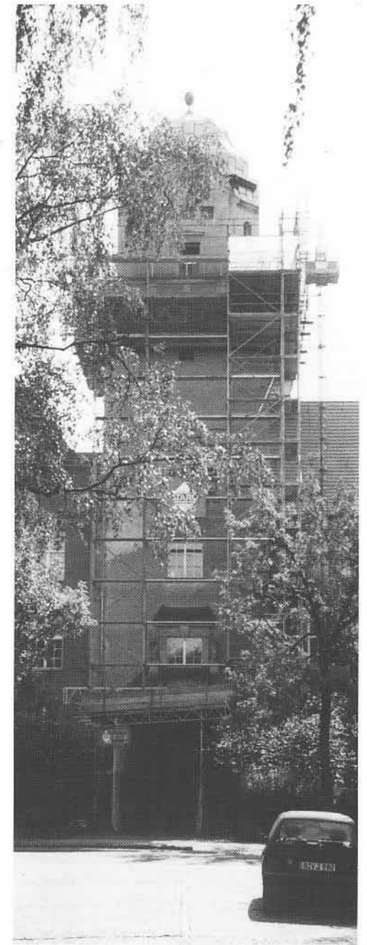
Eingerüsteter Turm über dem Schulhof
