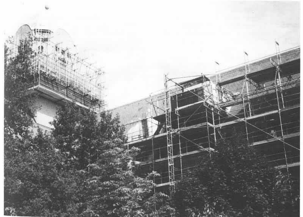
Im Spätherbst sollen die Gerüste fallen
