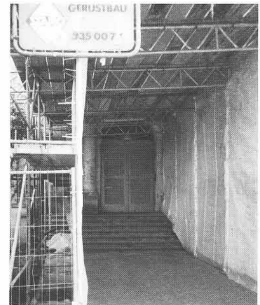
Der Tunnel zur Schultür
