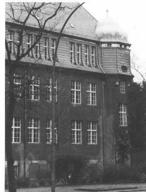
Teil des renovierten Westflügels
