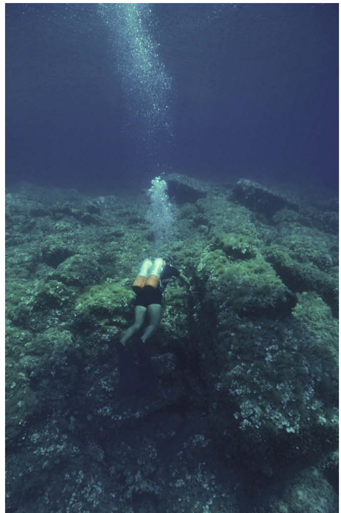
Fig. 10. Capo Malfatano (Teulada – Cagliari). The breakwater.
