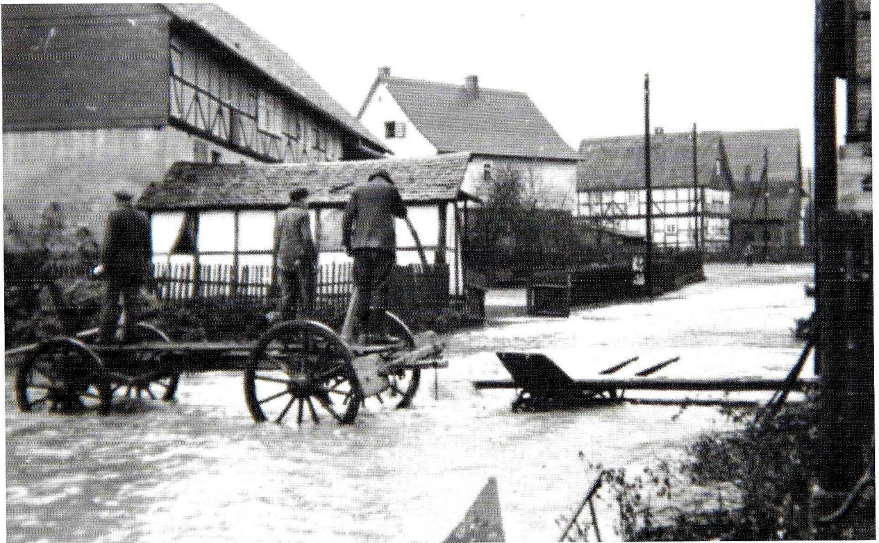
Hochwasser im Bruchweg
