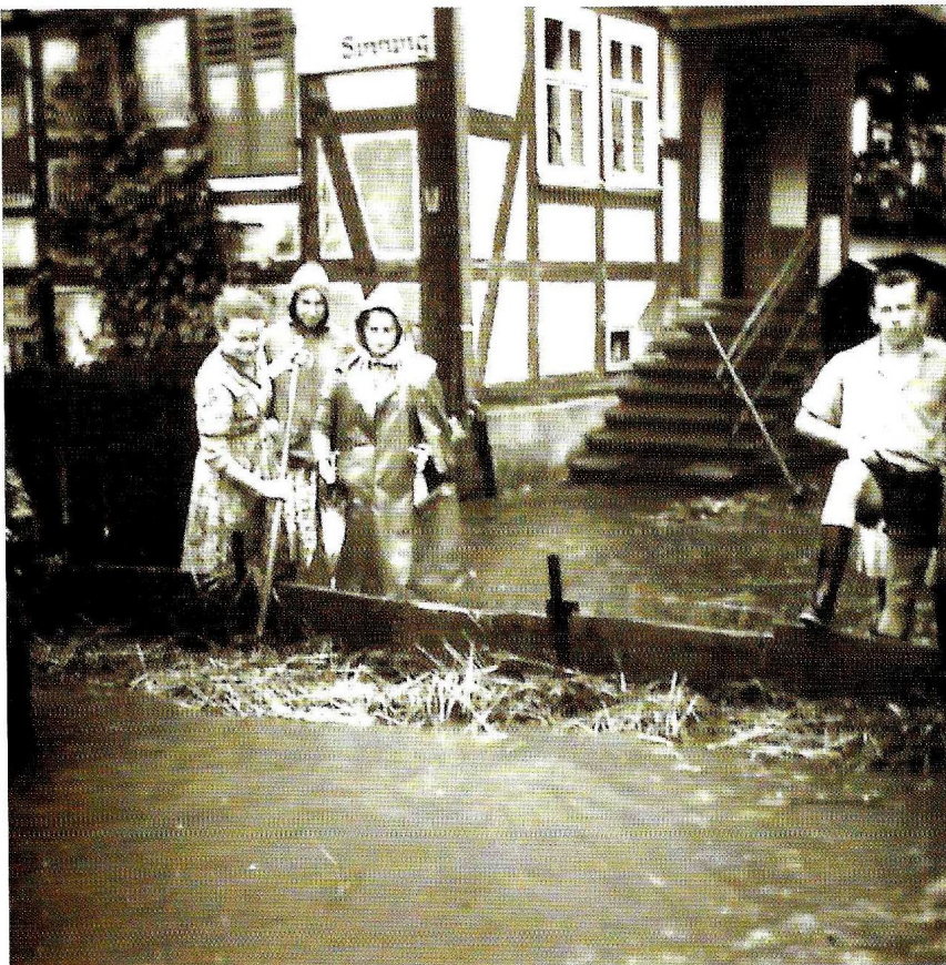
Errichten einer Barrikade bei Sinnings
