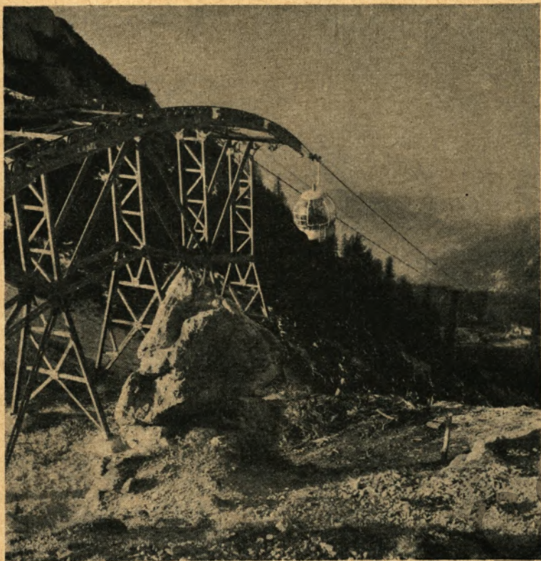
Auf halber Höhe liegt die Zwischenstation. Die Jennerbahn ist deshalb noch ungewöhnlich, weil sie ihrem Prinzip nach aus zwei an der Mittelstation gekuppelten Bahnen besteht. Der Antrieb liegt in dieser Mittelstation gemeinsam für beide Strecken, die Kabinen werden hier unmittelbar von einem Drahtseil auf das andere überführt. Man erkennt auf dem Stahlgerüst auf unserem Bild die Rollen, auf denen das Seil sich bewegt.
