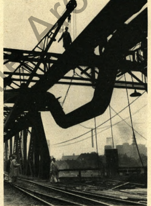
Es hat geklappt: Der neue Rohrbogen paßte haargenau in die Lücke. Nach dem Verschweißen wurde noch einmal wie vor Beginn der Montage Stickstoff durch die Leitung eingeblasen, ehe sie dem Betrieb übergeben wurde.
