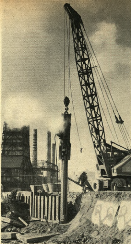
▲ Der Absetz-Kipper, den wir in Nr. 13 der Werkzeitschrift vorgestellt haben, soll den Transport der Schlacke vom Martinwerk zum Schlackenloch jetzt ausschließlich besorgen. Deshalb wird die zum Teil gerammte Spundwand am Schlackenloch vollendet.
