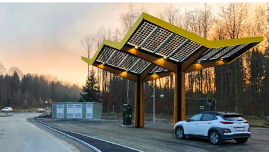
Die Schnellladestation auf der A1 bei Suhr (AG).
