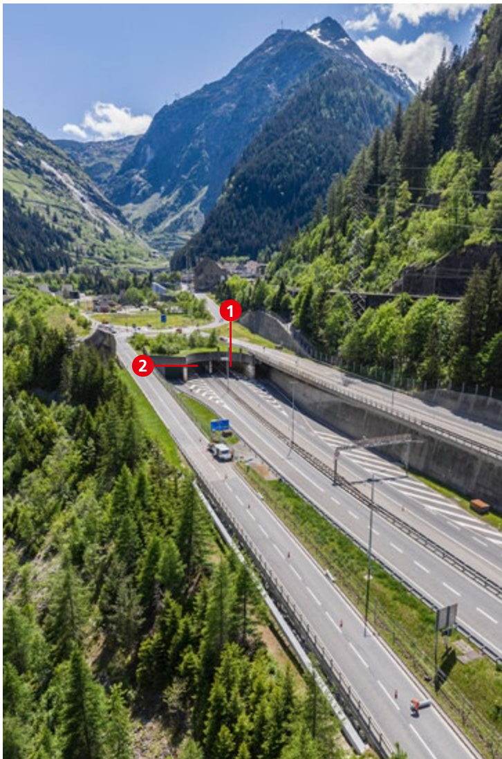
(1) Die Einfahrt am Nord-Portal des Gotthard-Strassentunnels bei Göschenen. (2) Hier wird die Ausfahrt der zukünftigen zweiten Röhre sein.
