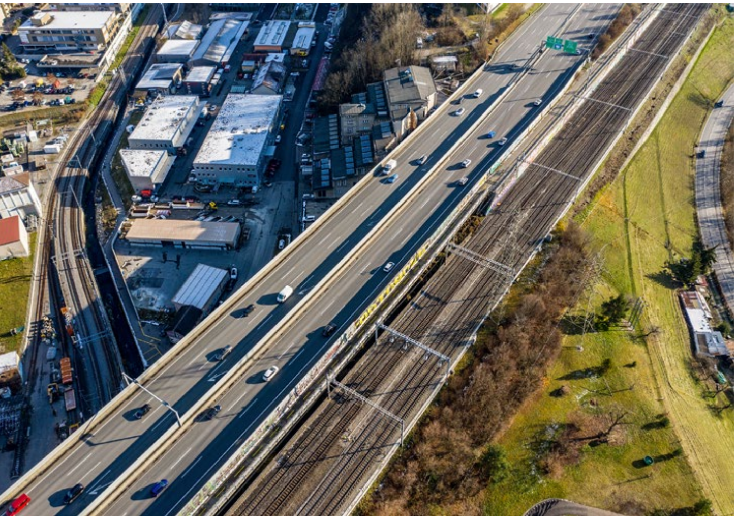
Die A1 bei Ittigen auf der Nordostseite der Stadt Bern.
