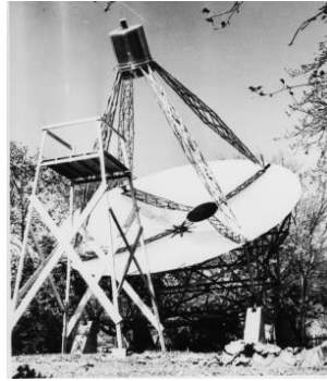
Abb. 2. Reber's Radioteleskop
