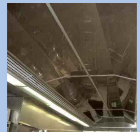
■ Hygienisch einwandfrei und ohne Brandgefahr: eine blitzsaubere Abzugsdecke.
