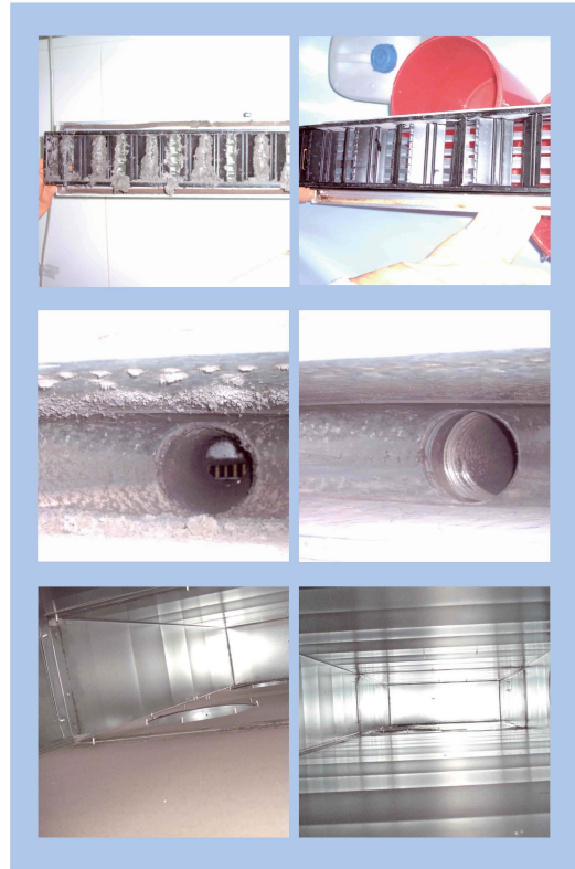
■ Oben: Abluftgitter vor und nach der Reinigung. Mitte: Eine Kamerainspektion verdeutlicht das Ergebnis. Unten: Vom Staub befreiter Abluftkanal.
