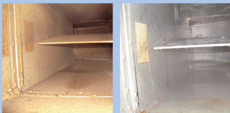
■ Oben: Eine Abluftanlage glänzt nach der Behandlung wieder. Mitte: Abluftaggregat vor und nach der Reinigung. Unten: Die massiven Fettablagerungen konnten vollständig entfernt werden.
