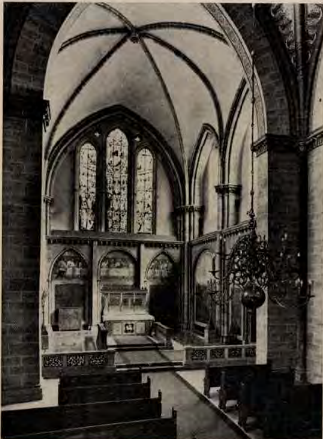
Vierungspfeiler mit Verkleidung
