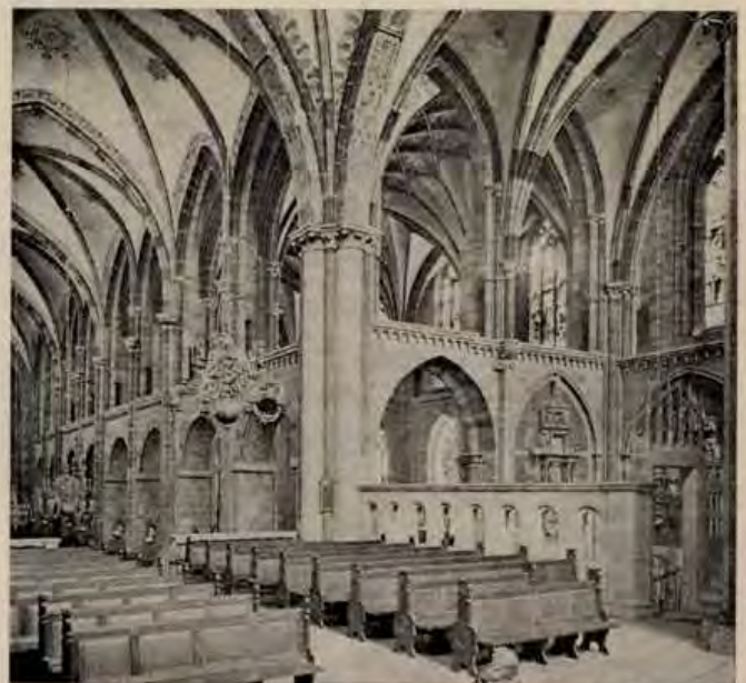
Vierungssäulen ohne Verkleidung
